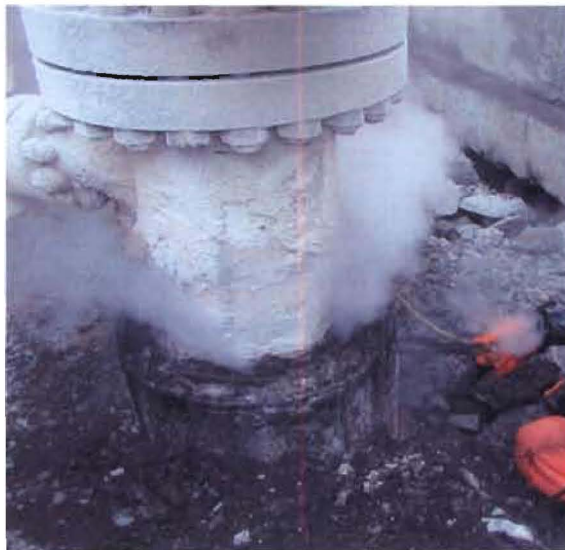
Mynd 8. Búið að fjarlægja kjallaragólfíð, holan heit og hvæsandi gas og vatn út á milli fóðringa.
