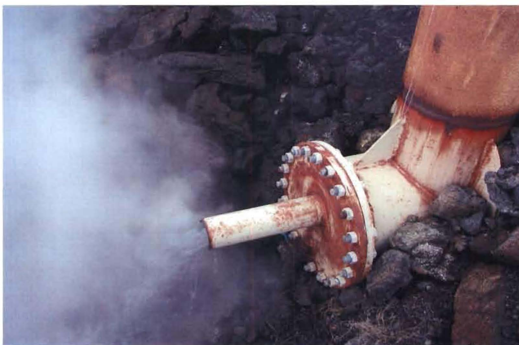
Mynd 5. Vatn úr hljóðdeyfi 18. janúar 2002, eftir að runnið hafði frá holunni nokkra hrið.
