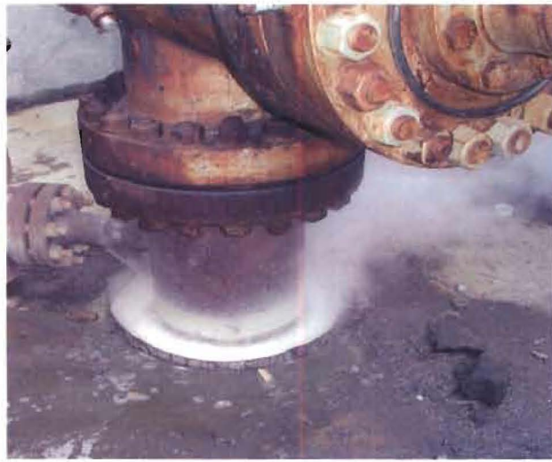
Mynd 7. Holutoppur farinn að hitna og vatn sýður milli fóðringa.
