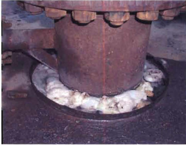
Mynd 6. Kaldur holutoppur, froða situr á vatni milli fóðringa.
