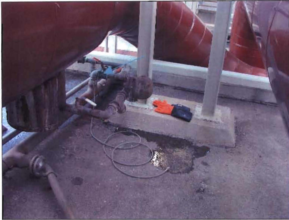
Mynd 2. Sýnatökustaður á þéttvatnslögn, orkuver 3.
