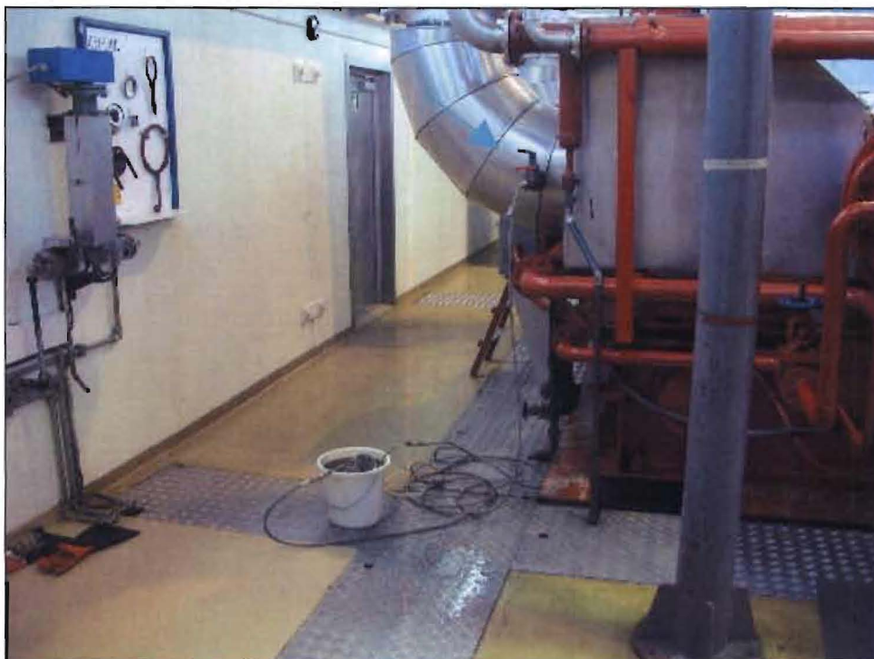
Mynd 1. Sýnatökustaður á gufulögn við hverfil, orkuver 3.
