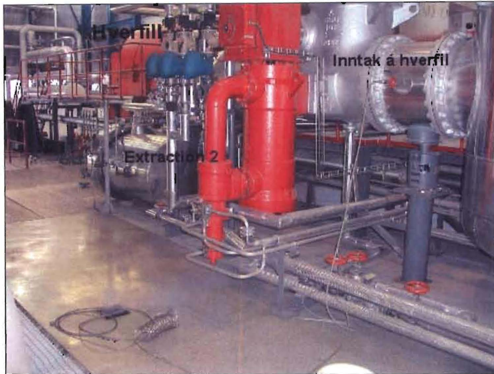
Mynd 12. Sýnatökustaðir við inntak á hverfil, orkuver 5.
