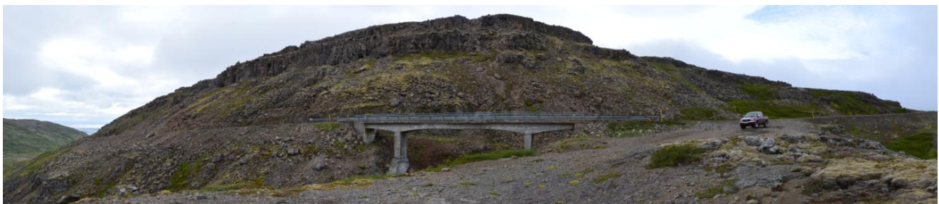
Mynd 14. Mynd tekin fyrir neðan stöð 6050. Mynd: NAVE/SV.
