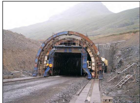
Mynd 4.4.2. Bygging vegskála í Fáskrúðsfjarðargöngum (mynd: Sigurður Oddsson, 2004).
