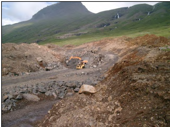
Mynd 4.4.1. Unnið í forskeringum í Fáskrúðsfirði (mynd: Sigurður Oddsson, 2003).
