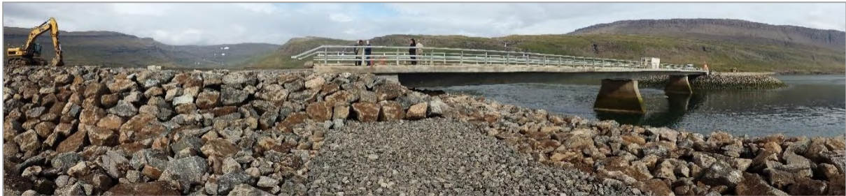
Mynd 4.2.1. Framkvæmdir við 117 m langa brú yfir Kjálkafjörð sumarið 2014 (mynd: Sóley Jónasdóttir).
