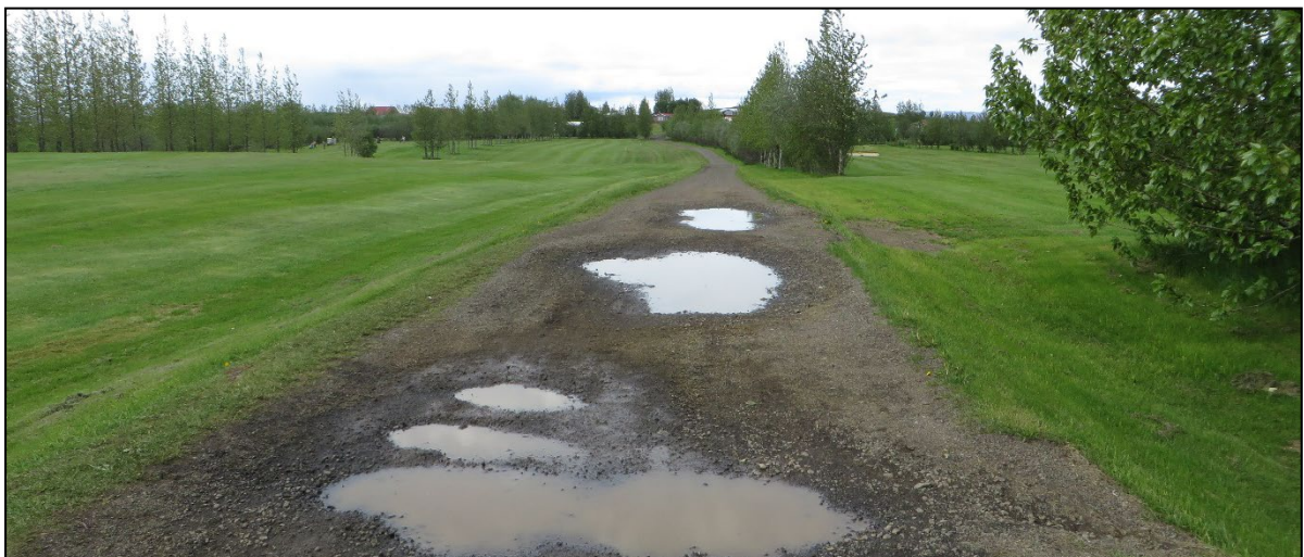
Mjólkurleið 010, horft til norðurs
