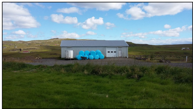
Bæjarstæði Unnarholts 001, horft til austurs
