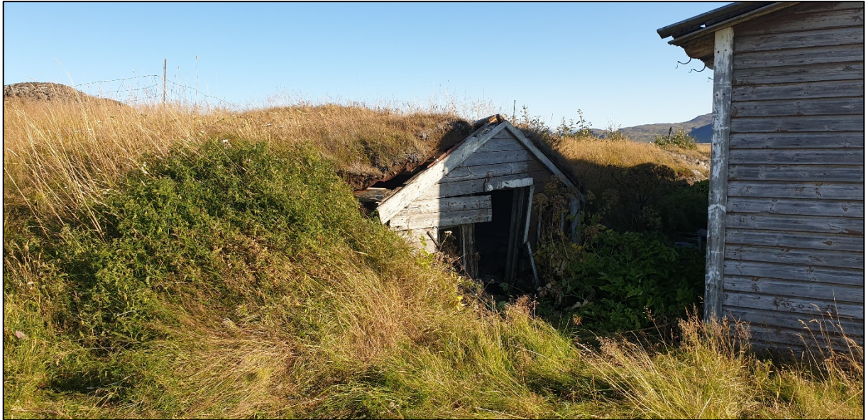
Hús 018, horft til NNV
