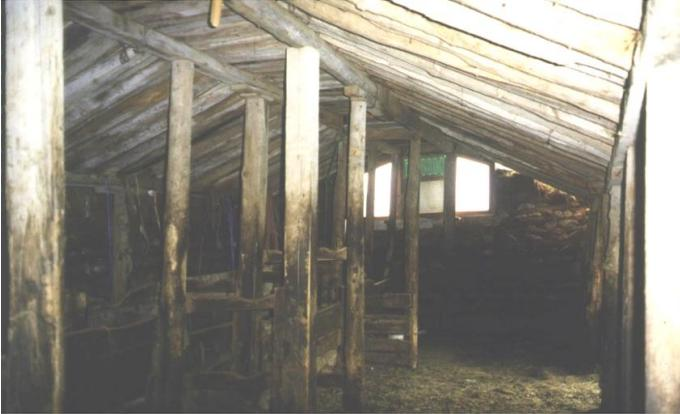
*Une étable avec un toit à pannes/poutres jumelles à Syðri-Hofdalir, dernièrement utilisée comme écurie. Les pannes du toit et les sablières hautes reposent sur des poteaux. L'espacement entre ces derniers correspond à la largeur disponible pour les stalles. Les chevrons sont placés entre les murs et les pannes du toit.*
