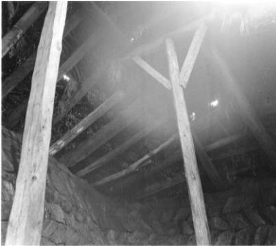
*Poteaux d'un toit à pannes/poutres jumelles dans une grange à foin. Les poteaux dressés sous les traverses sont renforcés par des contre-fiches pour supporter les pannes du toit. Les chevrons reposent sur les murs et les pannes. Sous les extrémités des chevrons, au-dessus des murs, se trouvent de petites dalles de pierre. Dans ce bâtiment, les chevrons sont faiblement écartés ce qui permet de placer la tourbe directement par-dessus. S'ils avaient été plus espacés,*
