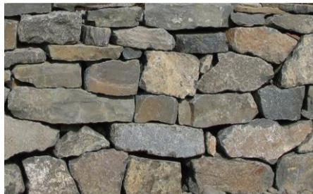
Les murs en pierres sèches, c'est-à-dire les murs construits sans l'aide de mortier, ne protégeaient pas du vent, mais ils étaient utiles pour la construction des remises et des murs champêtres. Il est nécessaire d'avoir l'expertise technique et les compétences manuelles requises pour la construction d'un mur solide et résistant aux intempéries, qu'il soit
