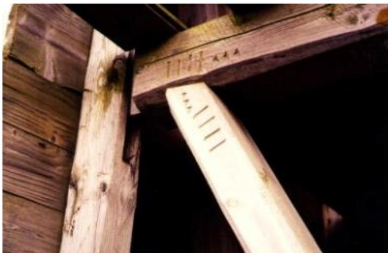
Partie de charpente en bois d'un bâtiment à Unastaðir, Kolbeinsdalur. L'ossature de toutes les pièces repose sur des pierres de fondation. Le bâtiment a été préfabriqué en Norvège aux alentours de 1930, et les éléments de la charpente importés en Islande prêts à être assemblés. La poutre est liée par tenon et mortaise à l'ossature et une cale est positionnée dans la poutre. L'extérieur est recouvert de bois, tandis que le lambris intérieur a été retiré.
