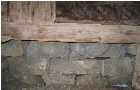
*A Reynistaður, le mur en bois repose sur une base en pierres sèches (þurrt grjótt). A droite sur la photo, un poteau cornier est posé sur une pierre de fondation. La sablière basse tient debout hors sol. Les extrémités des planches du mur sont fendues dans la poutre sablière.*
