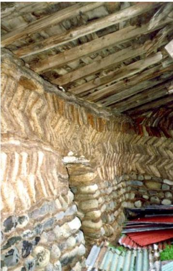
*Une manière courante de fabriquer les portes consistait à poser des poutres en bois en travers de l'entrée, puis de continuer à monter le mur en tourbe au-dessus de cette structure. Photographie : grange à Bakkakot, Vesturdalur, montrant une telle porte. On y voit aussi une poutre reposer sur le dessus du mur, sous les extrémités des chevrons. Ceux-ci sont d'abord recouverts par des árefti, et ensuite par de la tourbe.*
