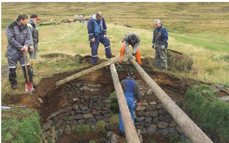
*Tyrfingsstaðir. Toit à pannes/poutres jumelles : les pannes ont été placées, et le premier chevron est mis en place. Il repose sur une petite dalle située au-dessus du mur.*
