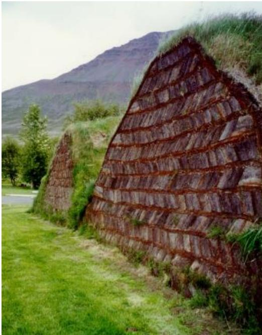
construction des murs, il est important de s'assurer que la tourbe est partiellement sèche afin qu'elle ne s'affaisse pas de trop, mais aussi qu'elle ne soit pas trop humide (pour éviter tout pourrissement). En coupant la tourbe, et en la taillant pour la positionner dans les murs, il était important de conserver les outils (faux, pelle, etc.) bien aiguisés.
