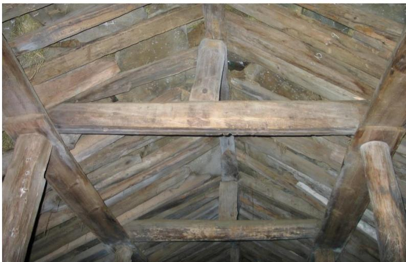
*Toit à triple pannes/poutres d'une grange à foin à Núpsstaður, Skaftafellsýsla. Les poinçons sont placés sur les entrails situés sous la panne faîtière. Les deux pannes ventrières reposent sur des poteaux.*
