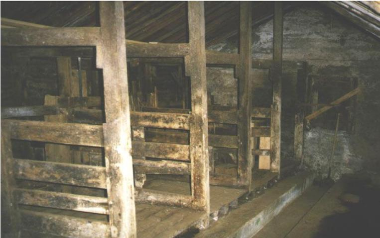
L'étable à Bustarfell, Vopnafjörður, a un toit à panne/poutre simple. L'écartement entre les poteaux supportant la panne faitière détermine la largeur des stalls pour chaque animal. L'écart entre les poteaux dépend aussi de la capacité des poutres à porter de lourdes charges. Un toit fermé couvert de dalles de pierres et surmonté d'une couche externe de tourbe est lourd. Le caniveau à crottin se trouve à l'arrière des stalls.
