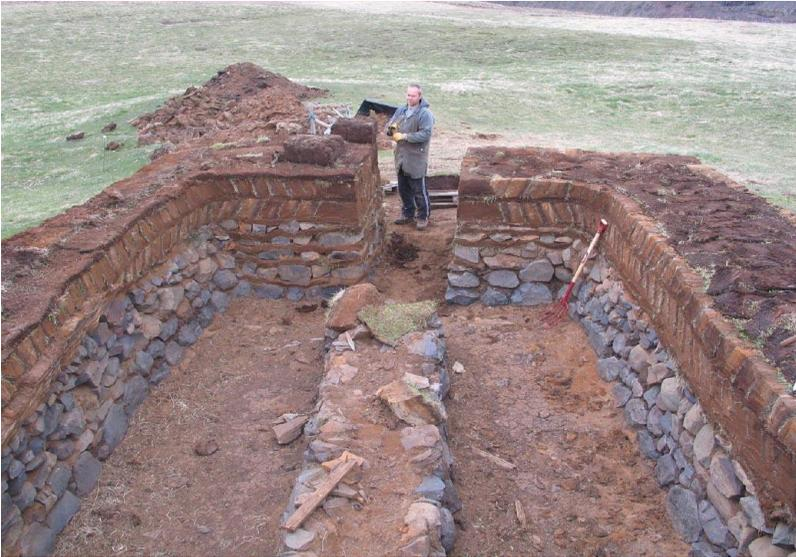
*Vue d'ensemble d'une bergerie comprenant deux enclos et dotée d'une mangeoire à fond pierreuse entre ces deux enclos. Les poteaux supportant les pannes du toit reposaient sur la base pierreuse. Dans la plupart des abris pour le bétail situés dans le nord de l'Islande autrefois, la base des murs était constituée de pierres et de tourbe alors que leur partie supérieure était uniquement formée de tourbe.*
