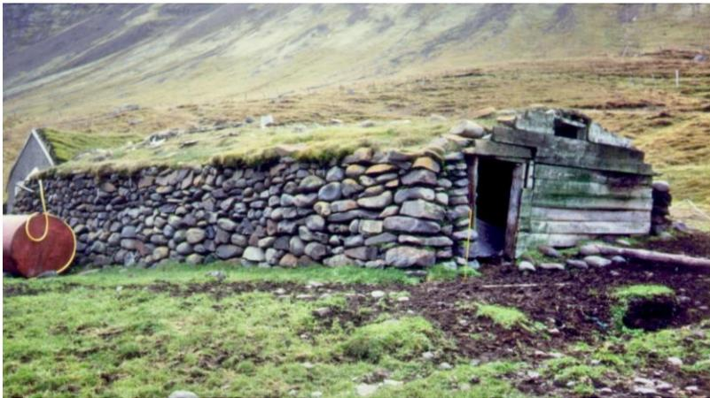
*Cette bergerie à Skatastaðir est construite avec des pierres provenant d'un pierrier. Le mur comprend également des strengur (bandes de tourbe). La bergerie a une mangeoire adossée à l'un des murs dans le sens de la longueur. La toiture est faiblement pentue, et les chevrons reposent sur des pierres plates placées sur le dessus des murs.*
