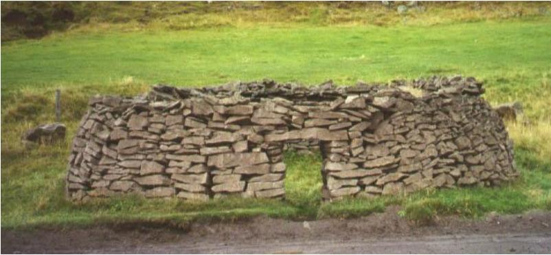
*A Litli-bær, Skötufjörður, se trouve un enclos à moutons construit avec des pierres provenant d'un pierrier situé dans une montagne avoisinante. Cet enclos est principalement formé de pierres plates.*
