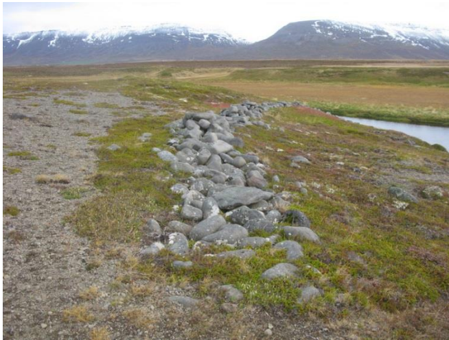
Mynd 37. Horft er eftir garðlaginu til austurs. Hrolleifsdalsá er til hægri á mynd.
