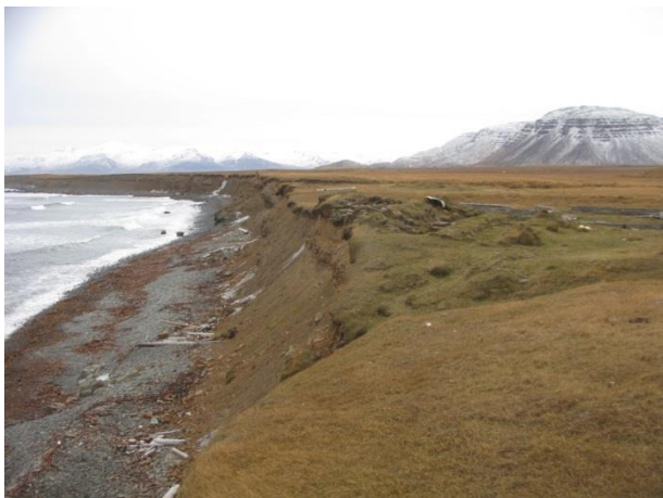
Mynd 66. Fjánhústóftin á sjávarbakkannum. Greinilega sést hvernig sjórinn hefur rofið sjávarbakkann og þar með hluta af tóftinni. Lengst til hægri sést í steinsteyptan grunn fjárhúsa sem byggð voru 1972.
