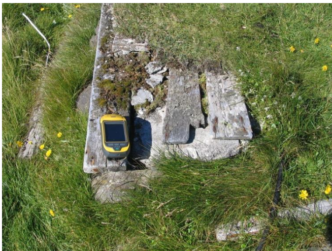
Mynd 15. Húsgrunnur (1803-44)? Grjóthleðsla er í útbrún en steinsteypt plata þar innan við og timburgólf eða fleki þar yfir.
