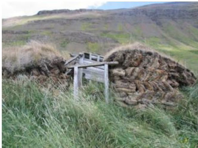
Mynd 7, Hólhús, horft til norðausturs á gafl nyrðri fjárhúsa (146332 - 228 - 13) þ.e. húsin í miðjunni. Ljós. GSS
