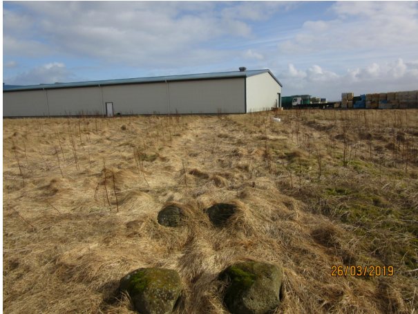
Mannvirki GK-096:031, horft til suðausturs
