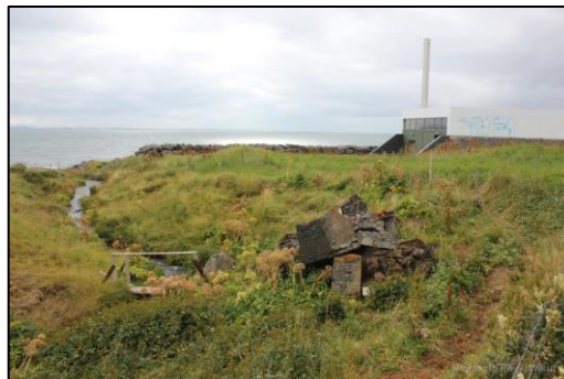
Mynd 18. Rústir rafstöðvar, horft í vestur.
