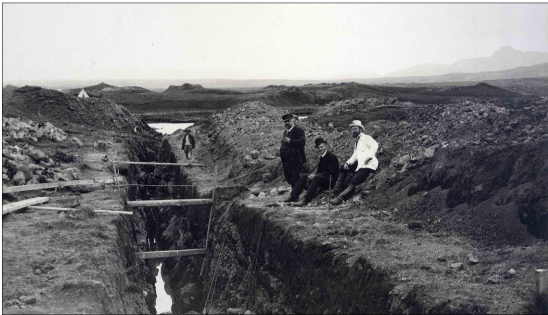
Mynd 4 Lagning vatnsveitunnar 1908 eða 1909. Yfirverkfræðingur framkvæmdanna, H.A. Hansen, stendur við skurðinn, en við hlið hans situr Knud Zimsen, þáverandi bærjarverkfræðingur Reykjavíkur. Í baksýn sjást Rauðhólar. 18
