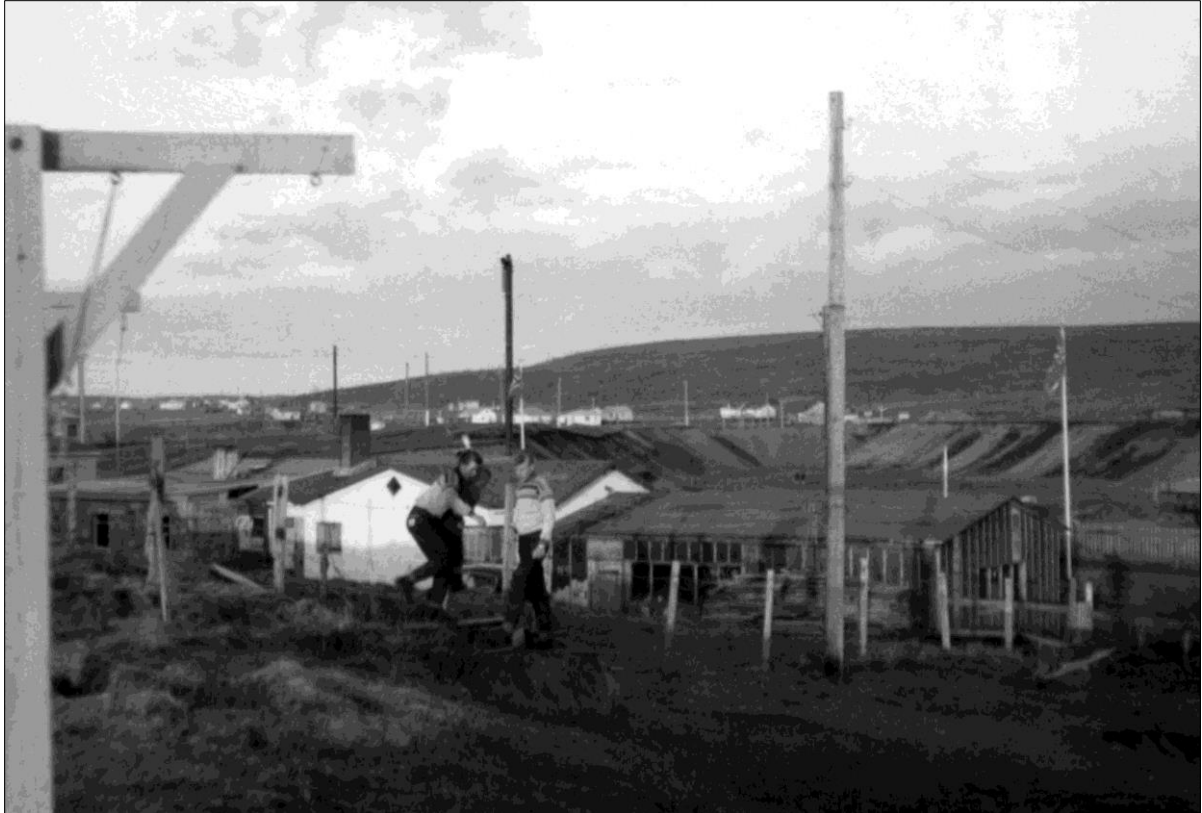
Mynd 14 Hér er húsið Skálará í forgrunni á ljósmynd frá 1960. Horft er til austurs og í baksýn sjást hús við Vatnsveituveg í Löngugróf og gryfja sem myndaðist vegna sandnáms á svæðinu en hún var jöfnuð út og grædd upp á níunda og tíunda áratug 20. aldar. 50
