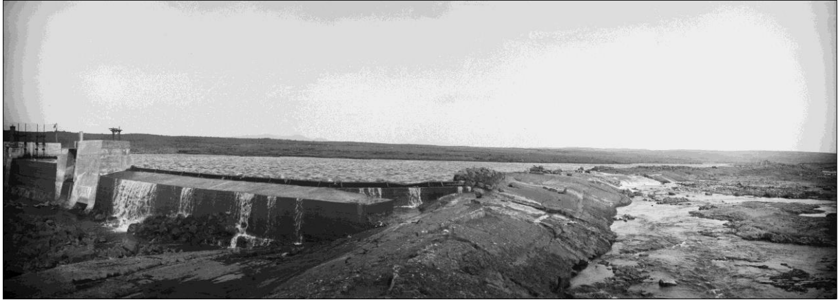
Mynd 20 Árbæjarstífla nýbyggð á mynd frá 1921-1925. Hér nær hún einungis yfir norðurkvísl Elliðaáanna að Blásteinshólma og hefur ekki verið lengd yfir suðurkvísl ána. 84
