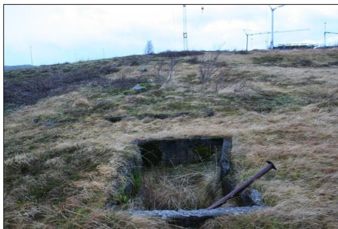
Mynd 32. Steypukassi (258-56), horft í suður.
