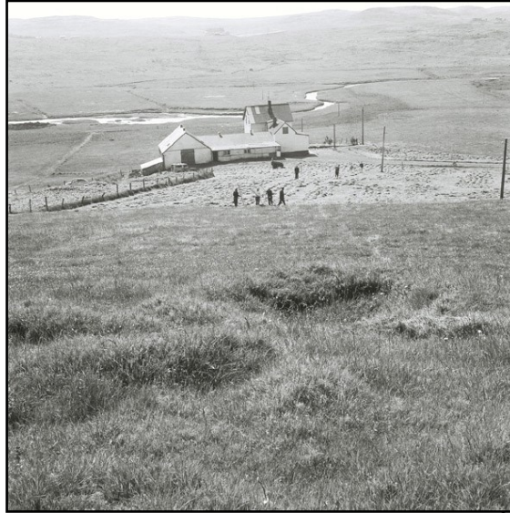
Mynd 5. Horft frá gamla bæjarstæðinu í suðsuðvestur að því nýja árið 1980. 26
