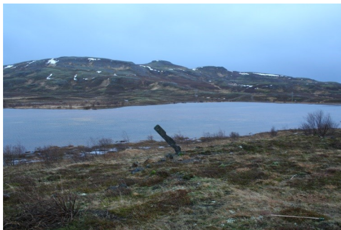
Mynd 30. Steypuleifar (258-54), horft í austur yfir Leirtjörn.
