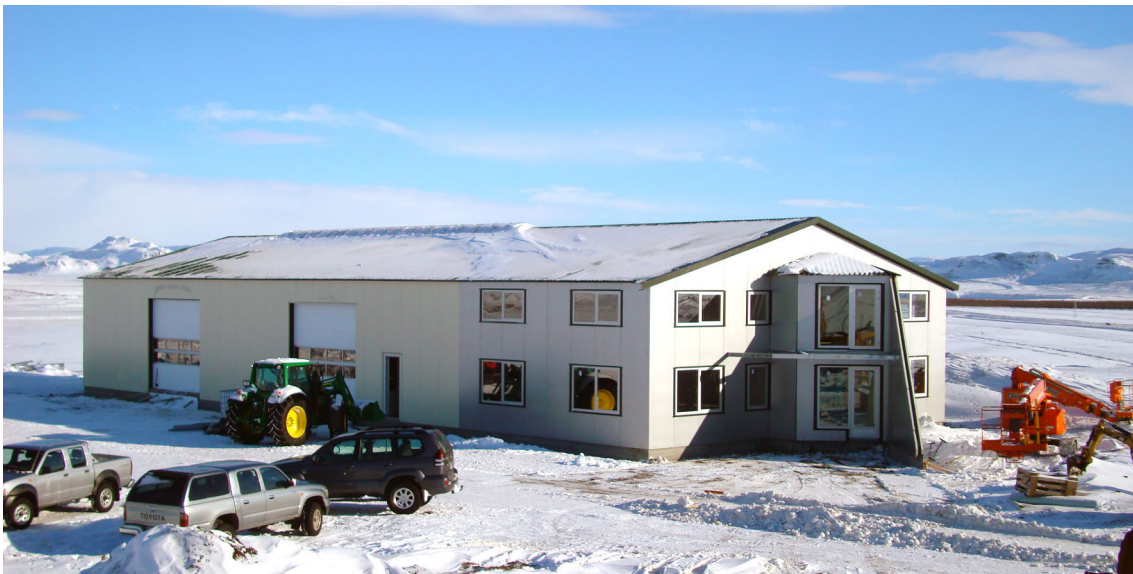
Mynd 16: Stálgrindarhús með skrifstofuaðstöðu á tveimur hæðum, Landstólpi . [16]
