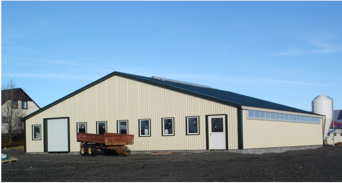
Mynd 17: Stálgrindarhús með með fódursíló við gaff, Landstólpi . [16]
