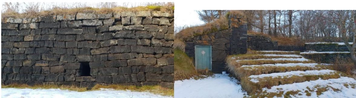
Hleðslur úr húsi Bárðar Sigurðssonar, SD-205:047. Á mynd til vinstri er horft til norðurs á fjósvegg og í honum sést gat sem var frá fjósi og yfir í „Skítahús“ norðan við. Á mynd til hægri sést Skítahúsið sem enn er undir þaki og tröppurnar upp í fjósið.
