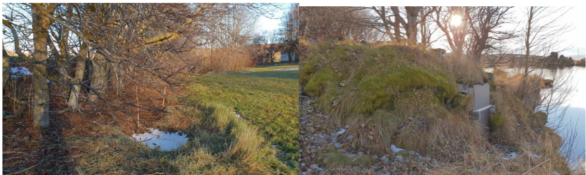
Brunnur SB-205:048. A mynd til vinstri er sjálfur brunnurinn (borft til norðurs) en dælubúsið á mynd til hægri (borft til suðurs).
