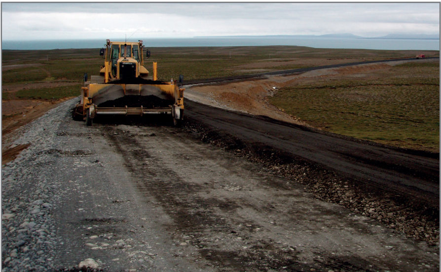
Útlögn burðarlags. Norðausturvegur í Pistilfirði. (RJÓ).
