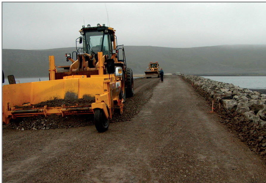
Útlögn burðarlags með malardreifara. Norðausturvegur við Lónsós. (RJÓ).
