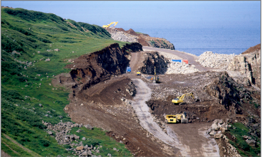
Unnið við skeringu (nær) og háa fyllingu úr grjóti (fjær). Norðausturvegur um Fjallahöfn. (VAI).
