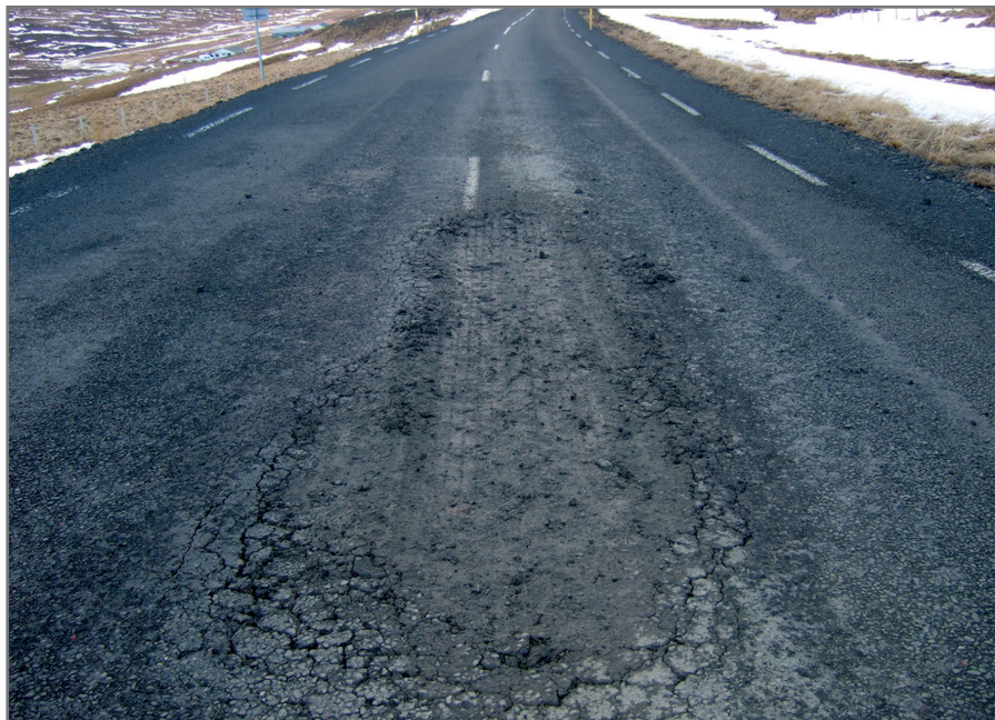
Skemmdir í slitlagi sem stafa af óhæfu burðarlagi sem unnið var úr sprengdu bergi. (VRP).
