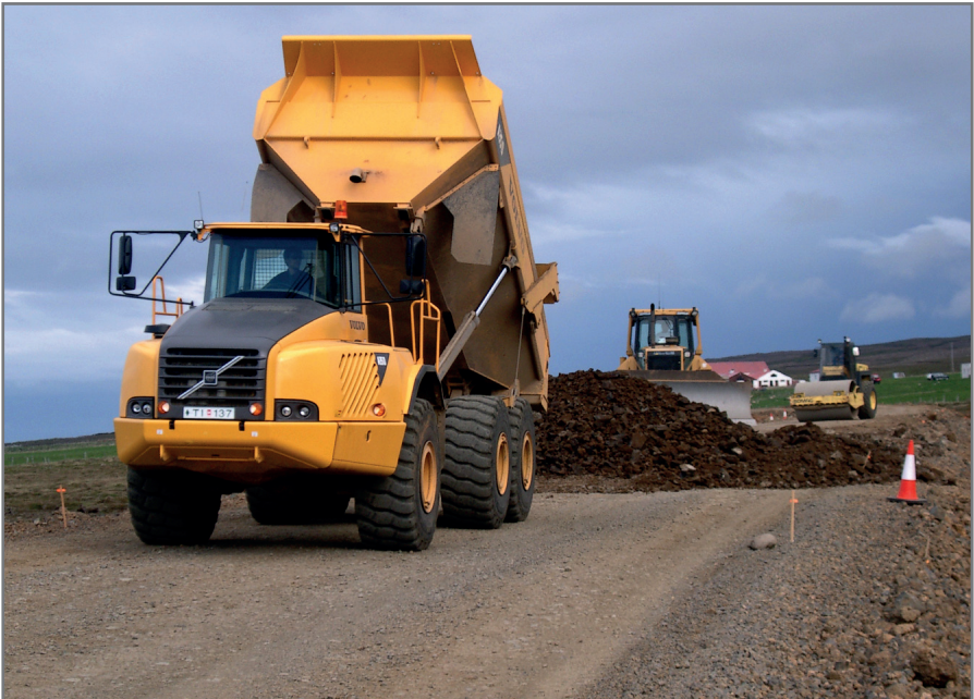
Útlögn styrktarlags. Norðausturvegur um Tjörnes. (RJó).
