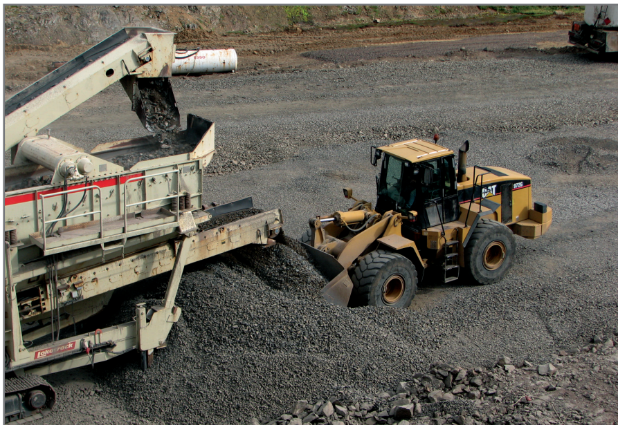
Mokað undan færibaldi jafnharðan. Lítil hættu á aðskilnaði. Skering á Tröllatunguheiði. (Haf).
