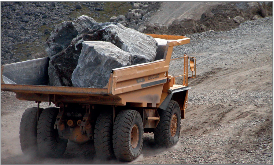
Grjótflutningar á búkollu. Norðausturvegur um Fjallahöfn. (RJÓ).
