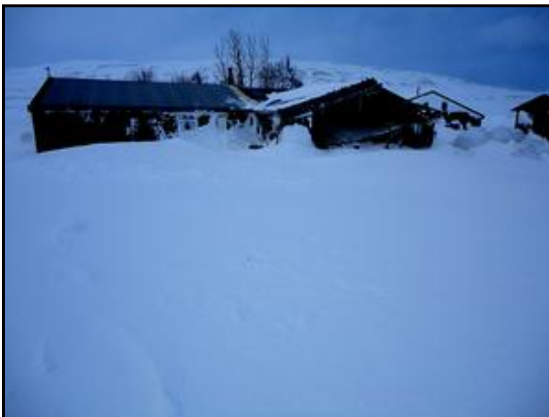
Mynd 7. Snjóflóð á bæinn Veisusel í Fnjóskadal. Greinilega sést hvar flóðið stöðvaðist á húsinu.
