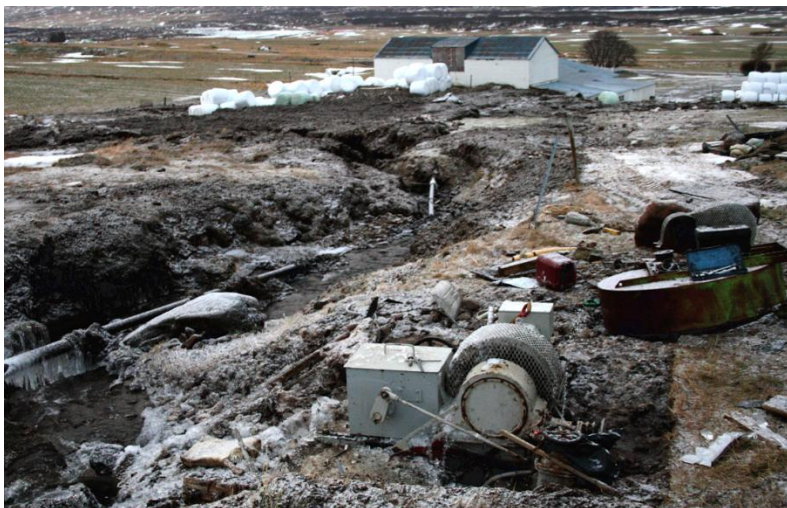
Mynd 4. Séð niður eftir farvegi bæjarlækjarins. Fremst er vatnsvél rafstöðvarinnar en flóðið reif rafstöðvarhúsið með sér og rafalinn frá vélinni. Ljósmynd: Jens Hilmarsson.
