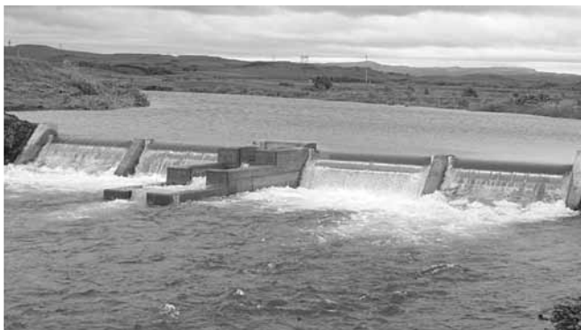
2. mynd. Fyrirstaða með fiskteljara í Kálfá. Fyrirstöðunni er ætlað að beina fiski um gönguþrepin sem eru í miðri fyrirstöðunni og þar ofan við er teljari sem telur og tekur hreyfimyndir af hverjum fiski.
