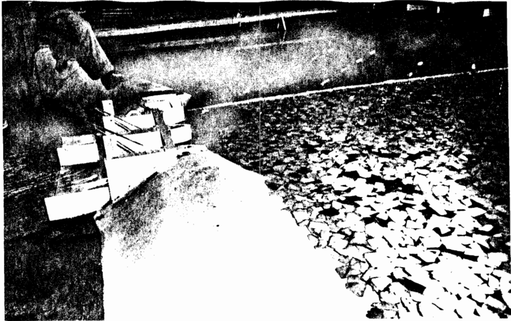
Mynd nr. 6 Hrauneyjafossvirkjun, ísbreiða á inntakslóni flotbrú til varnar íss
