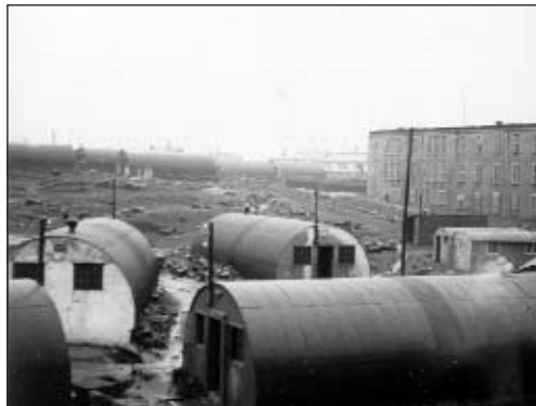
Herskálarhverfi voru sett á flest auð svæði í bænum og urðu síðar íbúðarhverfi
