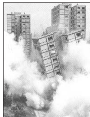
Verið að sprengja hverfi í Lyons vegna galla þess
