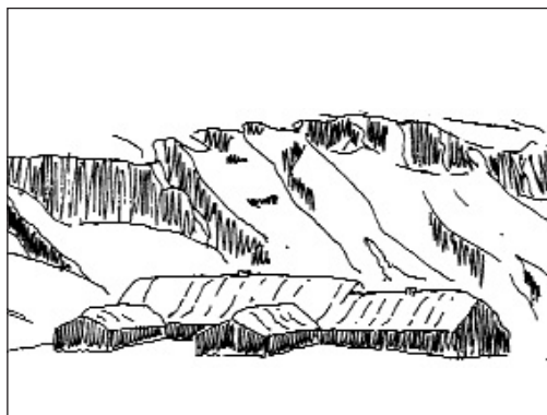
Líklegt er að landnámsbær Ingólfs hafi verið líkur þjóðveldisbænum
