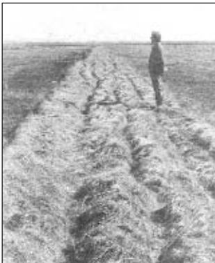
Yfir ófærar mýrar var hlaðið upp torfbrúm
