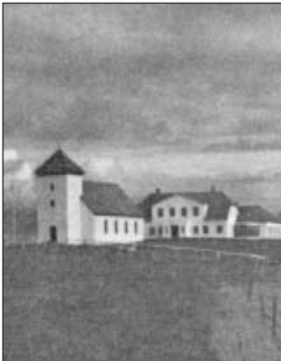
Á Bessastöðum risu byggingar á 18. öld
