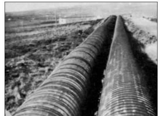
Tréþrýstipípur sem flytja vatnið að stöðv- arhúsinu. Elliðavatn er miðlunarlónið
