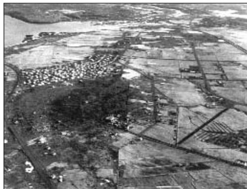
Ný byggingarsvæði hafa löngum verið í lausum tengslum. Hér Langholtshverfi
