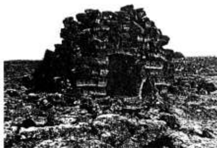
Einu varðveittu byggingar eru þær sem hafa þakhvelfingu úr hlöðnu grjóti.
