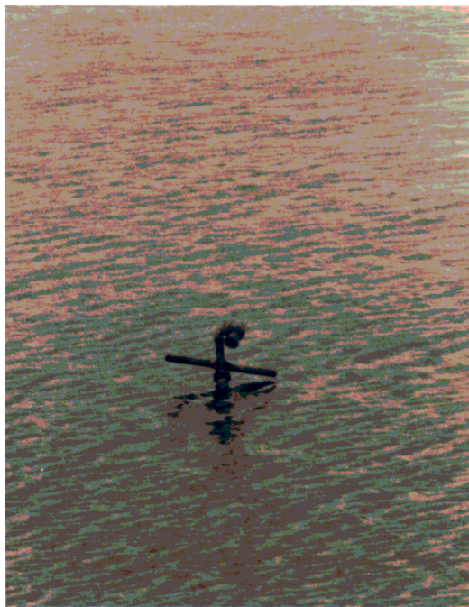
MYND 2. Urriðavatn. Stútur holu 1 eftir að steipt hafði verið í hana árið 1977 (Ljós. Þórir Sveinbjörnsson).
