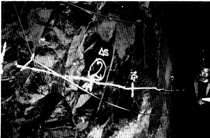
Ljósmynd 16. Oddskarð. Sprungumælingar í millistuðluðu andesíti (sjá mynd 17).
