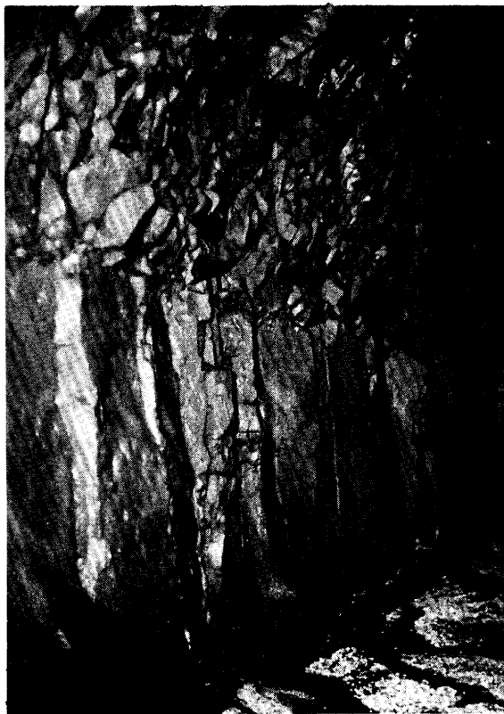
Ljósmynd 7. Aðrennslisgöng Búrfellsvirkjunar. Millistuðlað basalt í neðri hluta veggjar en kubbaberg í efri hluta veggjar og lofti.
