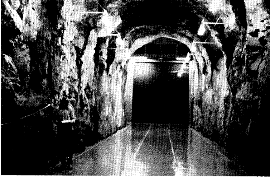
Ljósmynd 9. Laxárvirkjun. Stórstuðlað basalt í aðkomugöngum að stöðvarhúsi. Göngin eru ásprautuð innst.
