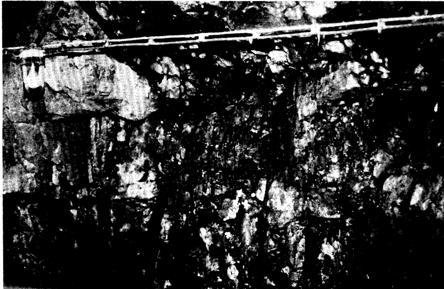
Ljósmynd 13. Grímsárvirkjun. Brotið basalt í austurvegg.
