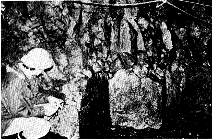
Ljósmynd 1. Írafossvirkjun. Skil milli stór- og millistuðlaðs basalts. Myndin er tekin í vesturvegg inn við stöðvarhús.
