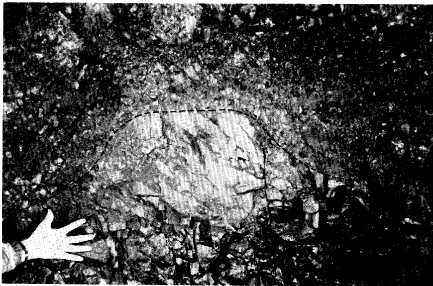
Ljósmynd 20. Oddskarð. Sandsteinn (neðan slitnu lfnunna) í gangavegg nálægt munna Norðfjarðarmegin. Setblandinn gjallkargi fyrir ofan.
