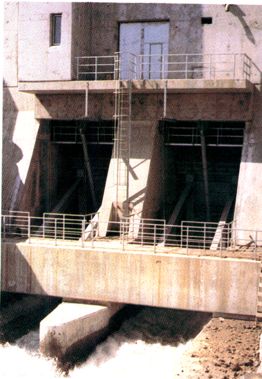
Ljósmynd 15 Botnloku í Sultartangastíflu í náttúrunni, lokur fullopnar og rennsli um 620 \text{ m}^3/\text{s} (ljósm. Verkfræðist. Vatnaskil).
