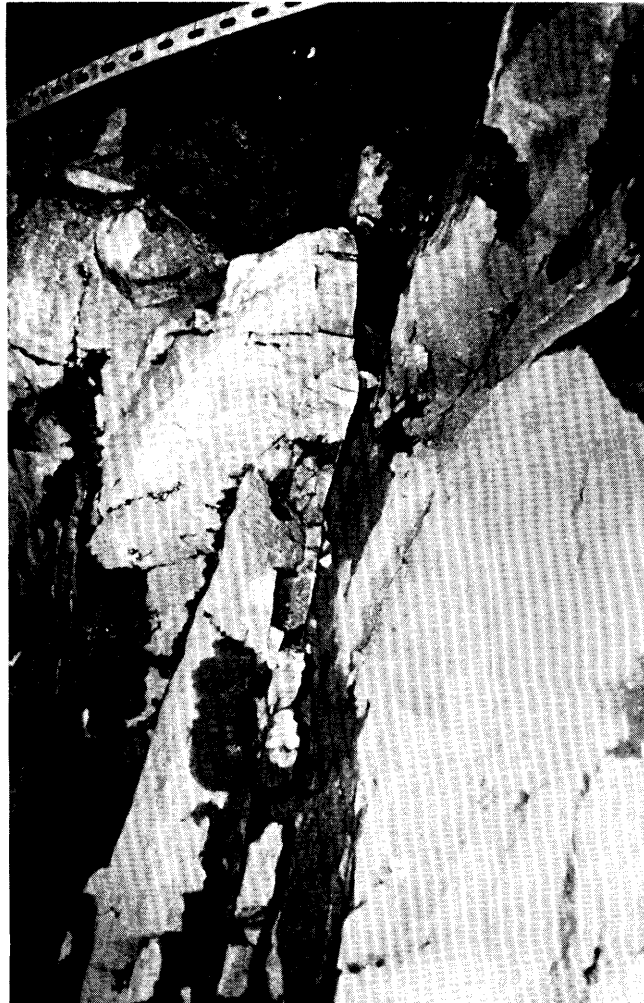
Ljósmynd 12. Austurhluti Austureyjarganga. Sprungubelti sem göngin skera skáhallt. Öryggisnet í lofti.
