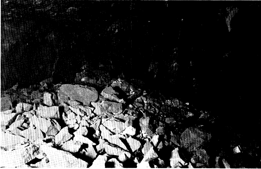
Ljósmynd 13. Myndin er tekin skömmu eftir sprengingu við vinnslustálið í Leirvíkurgöngum.
