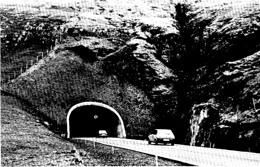
Ljósmynd 7. Vesturmunni Leynarjarönganga. Takið eftir lóðréttu sprungubelti til hægri.
