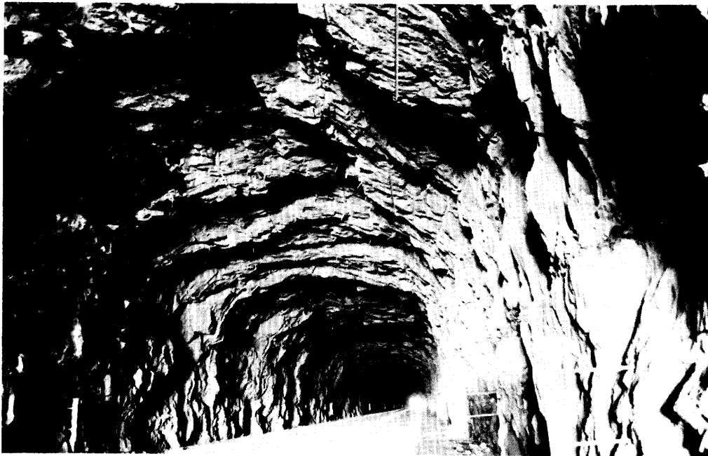
Ljósmynd 10. Dæmigert útlit Austureyjarganga. Ef myndin prentast vel má sjá bergbolta og borholuför í lofti.
