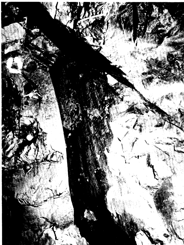
Ljósmynd 30. Stórstuðlað þóleift basalt í Hvalbagöngunum. Stór stuðlablokk hefur dottið úr veggnum (hamarinn neðst til vinstri er tæplega 40 cm langur).
