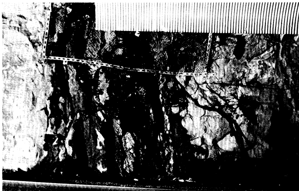
Ljósmynd 4. Vatnsleiðandi sprungubelti í Leynarjarögöngum. Takið eftir öryggisneti og vatnsskermi.
