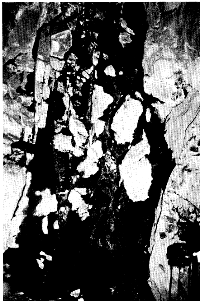
Ljósmynd 5. Vatnsleiðandi sprungubelti í Leynarjarðgöngum. Bergið er vandlega hreinsað („skrotað“) og ekki styrkt.
