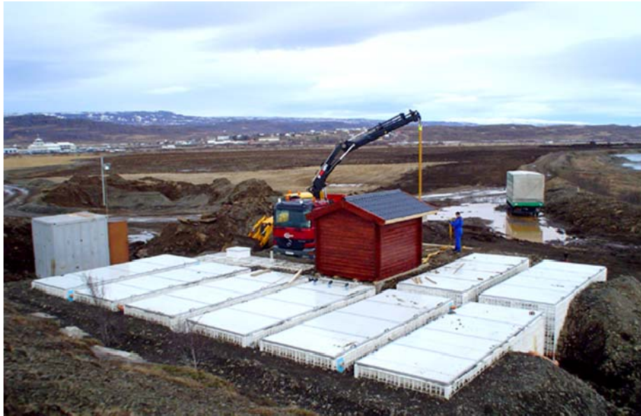
Mynd 2. Frá uppsetingu hreinsistöðvar á bökkum Eyvindarár á Egilsstöðum.
