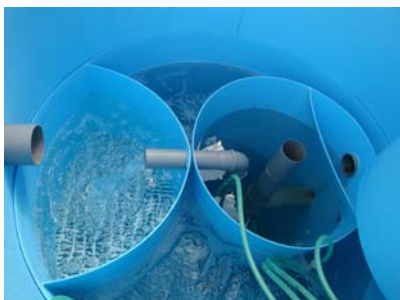
Mynd 6. Hreiniskref í Bólholt stöð fyrir 5-25 PE
