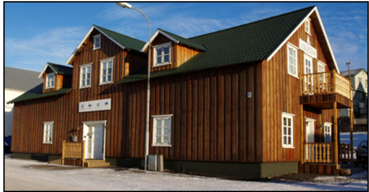
Mynd 4. Húsnæði ÞÞ á Húsavík, "Langaneshúsið"
