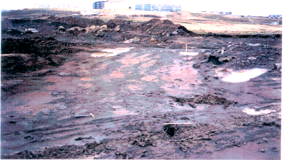
Mynd 4. Ljósmynd af sprungum í vegstæði, horft til suðurs. Stæði fyrir miðstólpa er uppgrafið, vinstra megin við skóflu.
