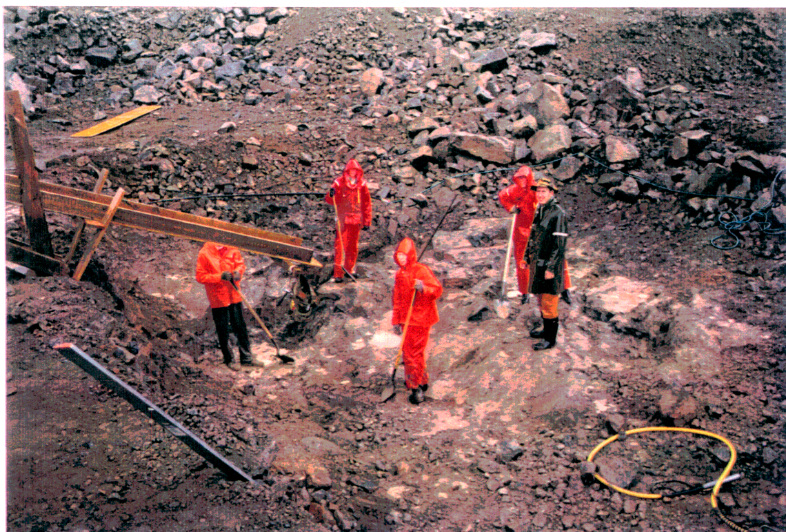
Mynd 6. Ljósmynd af sprungum í vegstæði, horft til suðurs. Stæði fyrir miðstólpa er uppgrafið, vinstra megin við skóflu.
