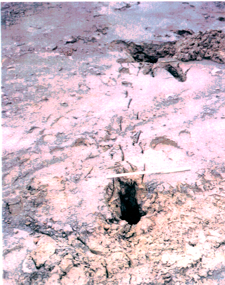
Mynd 4. Ljósmynd af sprungum í vegstæði, horft til suðurs. Stæði fyrir miðstólpa er uppgrafið, vinstra megin við skóflu.
