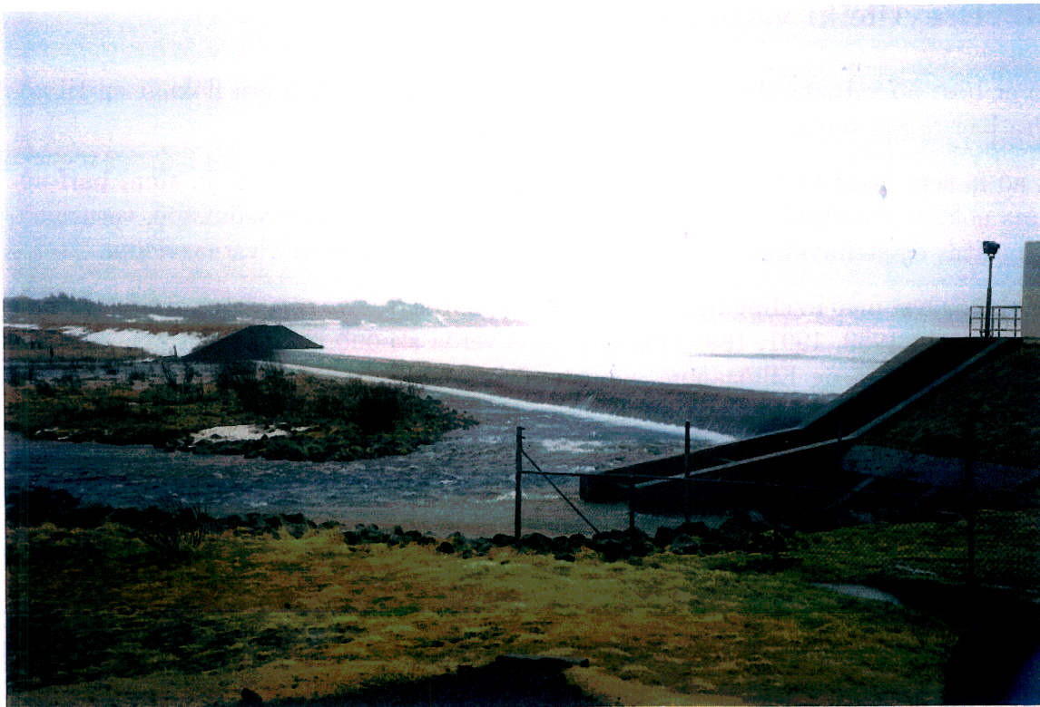
Mynd 4: Elliðavatnsstífla í leysingum í janúar 1999. Ís er yfir öllu vatninu. Laxastiginn er til hægri.
