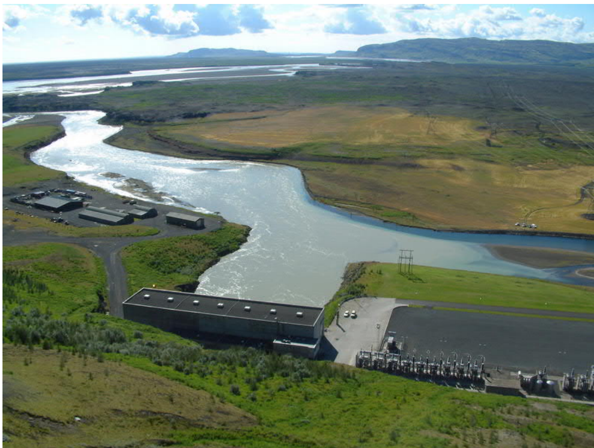
Mynd 5.2 Horft frá Sámstaðamúla yfir Búrfellsstöð, Fossá og Þjórsá í bakgrunni. Mynd er frá Landsvirkjun.
