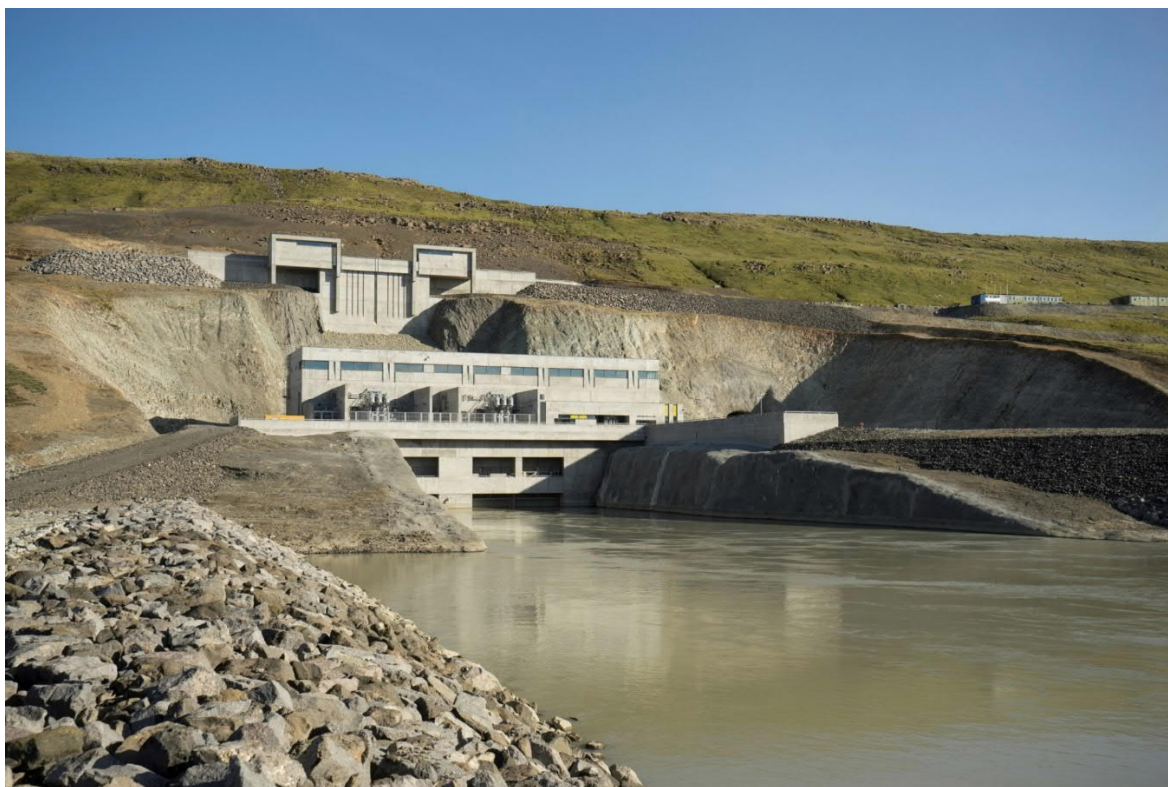
Mynd 5.10 Búðarhálsstöð 95 MW. Ljósmynd er frá Landsvirkjun.
