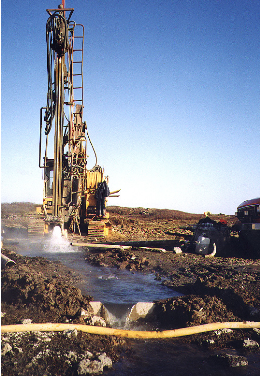
Mynd 9. Sjálfrennsli úr LA-01 farið að nálgast 25 l/s. V-yfirfallið er 20 cm djúpt og mælir mest 25 l/s.
