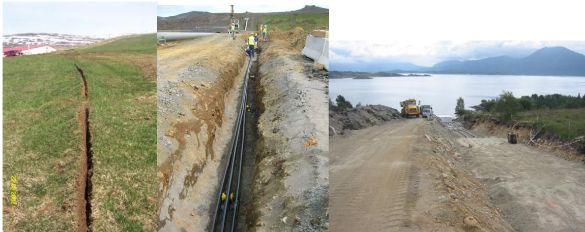
Mynd 24: Til vinstri lagning 11 kV strengs, fyrir miðju lagning 132 kV strengs og til hægri lagning 400 kV strengs.
