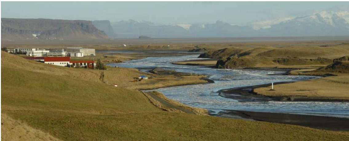
Mynd 27: Staðsetning kláfs í Skaftá við Kirkjubæjarklaustur. Horft er niður eftir ánni og sést mastrið á hægri (vestari) bakka vel.
