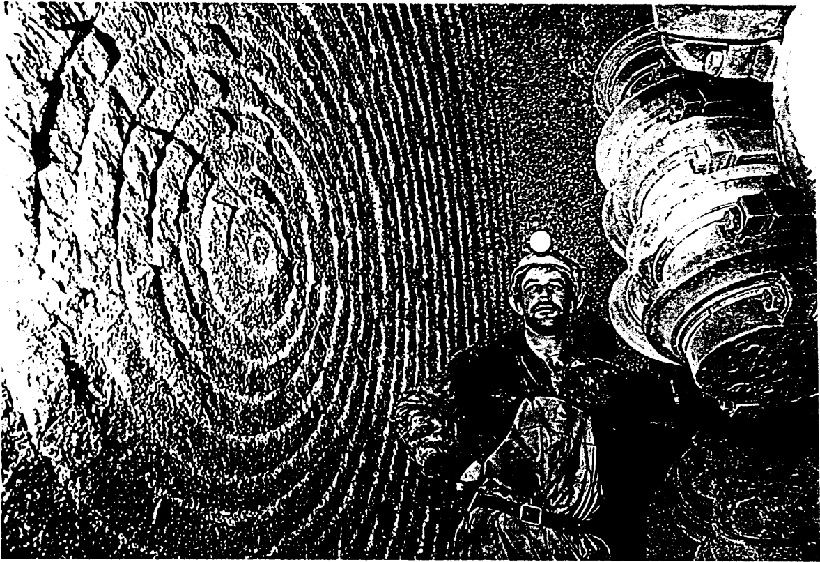
6. mynd. Jarðgangaborvél heilborar lárétt og hallandi jarðgöng. Brothjólin framan á borkrónunni rúlla hring eftir hring á stafni ganganna og flísa stöðugt úr berginu. Slík vél um 5,4 m í þvermál verður sennilega notuð við gerð aðrennslisganga Fljótsdalsvirkjunar.
