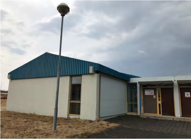
Inngangur, horft úr austri, 2019.
