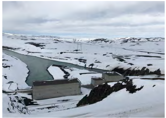
Stöðvarhús og tengivirkishús, horft úr austri frá inntakshúsi, 2019.
