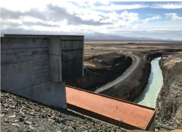
Norðvesturhlið inntakshúss, þak stöðvarhúss og frárennisskurður í baksýn, 2019.
