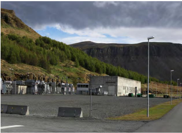
Búrfellsstöð, horft úr norðvestri. Útivrki í forgrunni, 2019.
