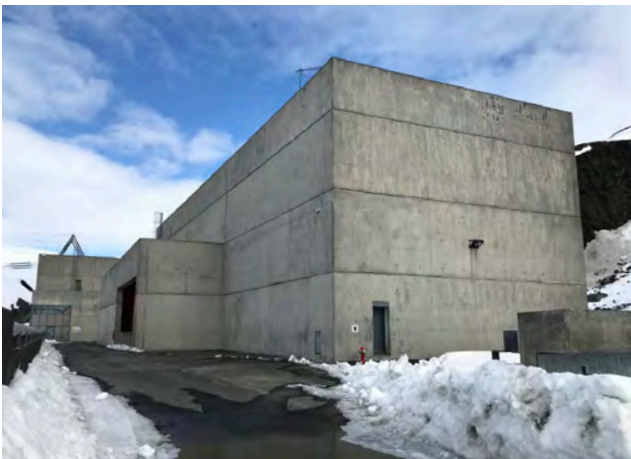
Stöðvarhús, horft úr suðvestri. Tengivirkishús í bakgrunni, 2019.
