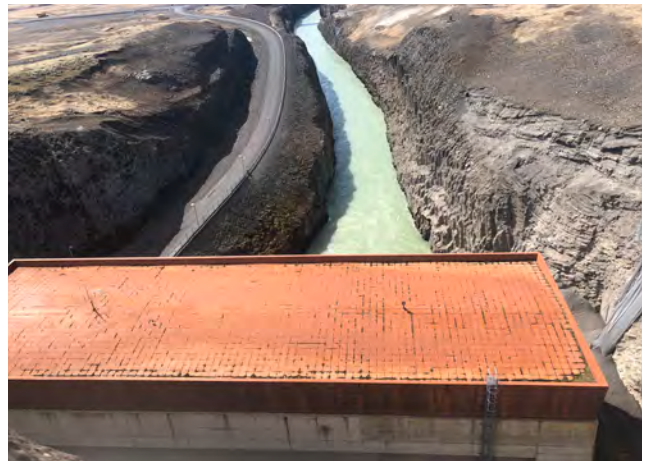
Norðausturhlið og þak stöðvarhúss, 2019.
