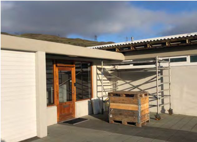
Inngangur að skrifstofuhúsnæði, horft úr norðvestri, 2019.
