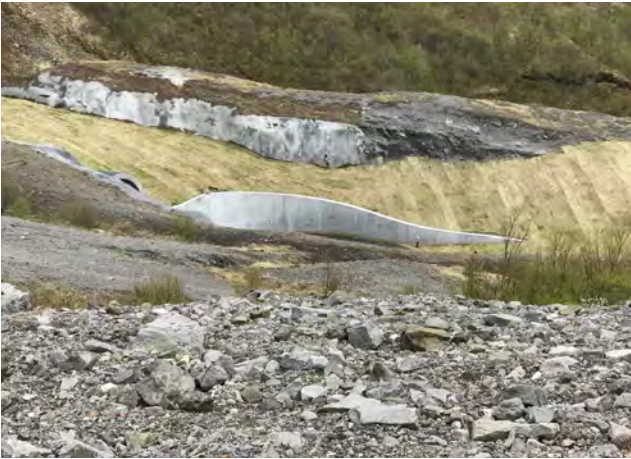
Aðkomustoðveggur, séð að ofan, 2019.
