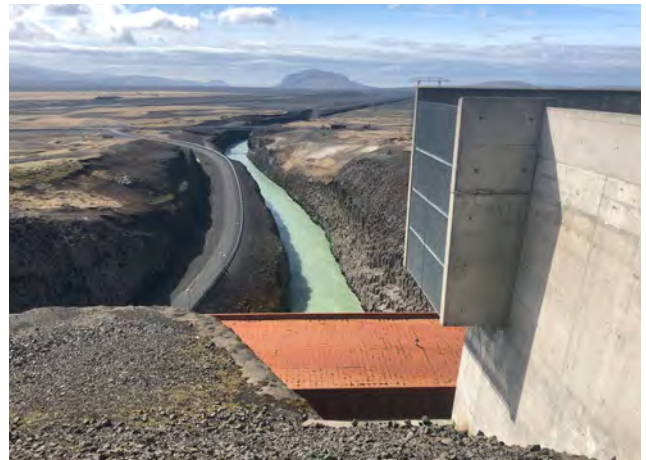
Norðausturhlið inntakshúss. Búrfell í fjarska, 2019.
