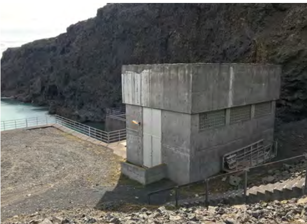
Inngangur að botnlokuhúsi er á austurgafli, 2019.
