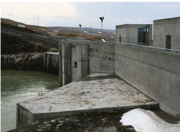
Inntakshús, horft úr norðaustri, 2019.
