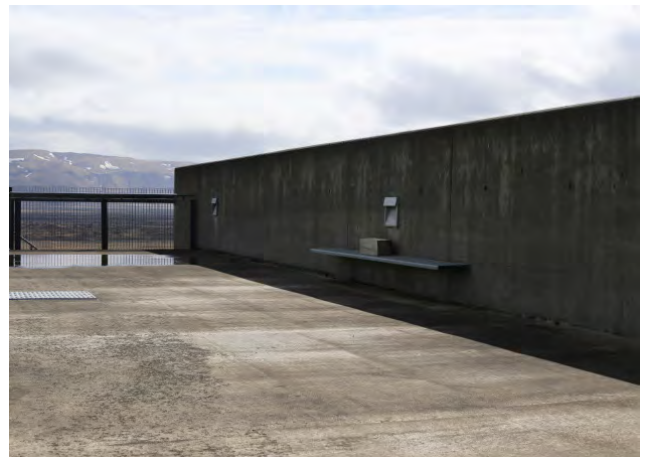
Norðausturhlið inntakshúss myndar aðkomu- og útsýnispall, 2019.
