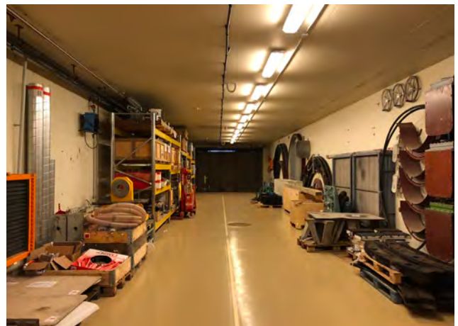
Bílskúr og geymsla stöðvarhúss, 2019.
