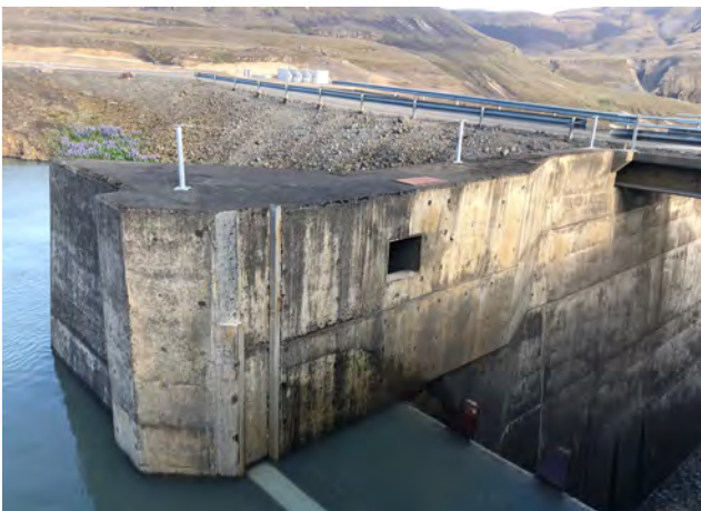
Kliflokumannvirki, horft til suðausturs. Útvirki Búrfellsstöðvar II í fjarska, 2019.
