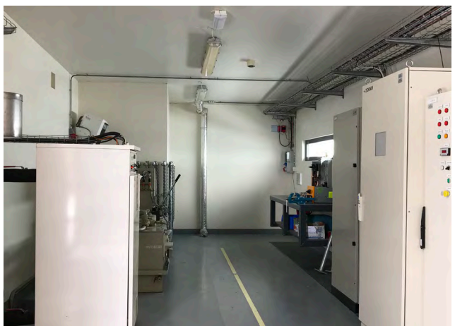
Komið inn í inntakshús, 2019.
