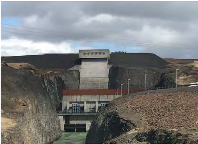
Stöðvarhús og inntakshús séð úr suðvestri, 2019.
