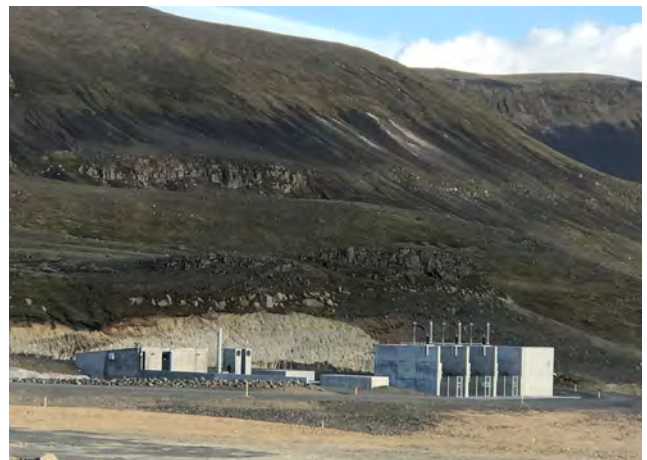
Inntakshús og útivirki séð úr norðvestri, 2019.
