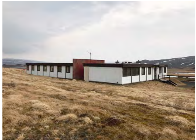
Starfsmannahús, horft úr suðvestri, 2019.
