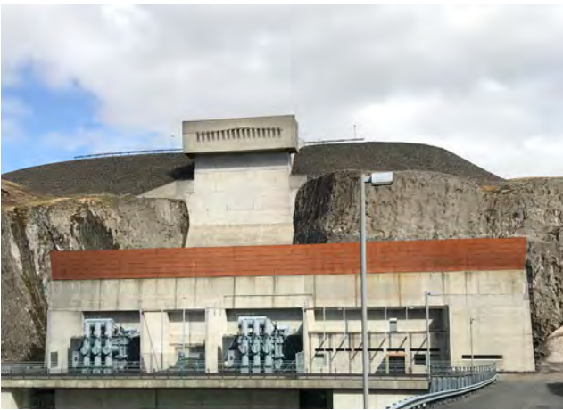
Suðvesturhlið inntakshúss, ofan stöðvarhúss, 2019.
