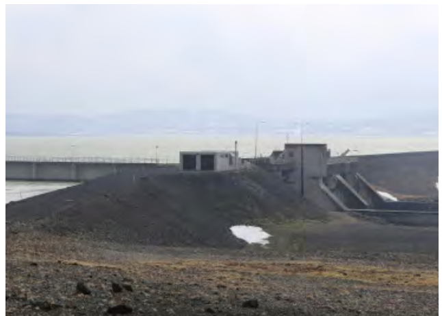
Lokuvirki, horft til austurs. Rafstöðvarhús í forgrunni, 2019.
