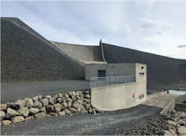
Botnlokumannvirki, horft úr norðvestri, 2019.
