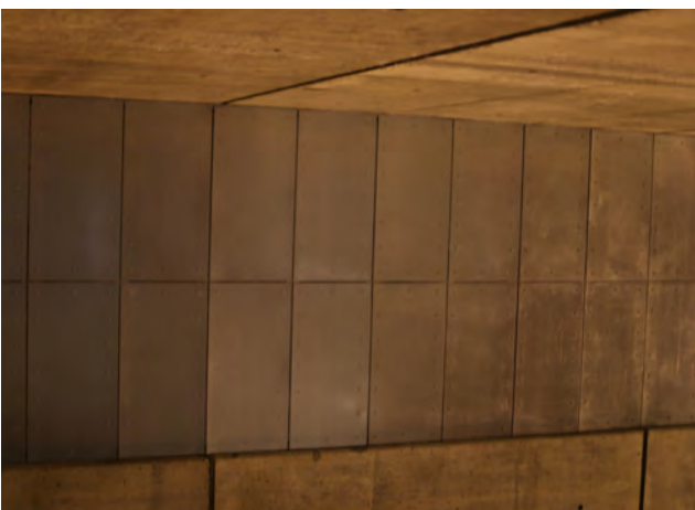
Stálplötur og steinsteypa innanvert í stöðvarhúsi, 2019.
