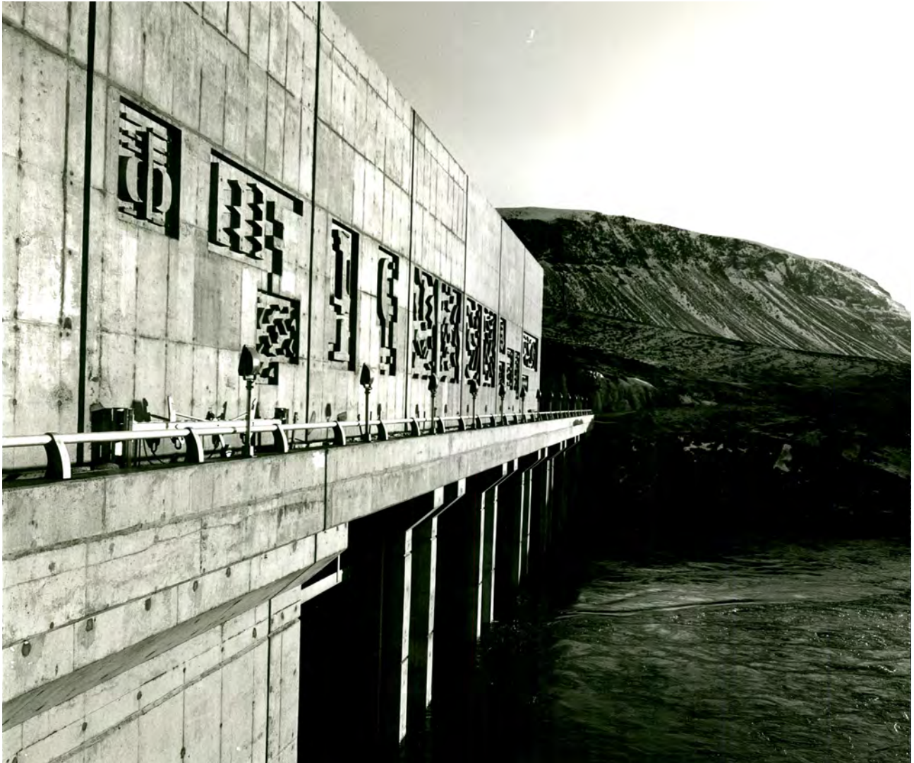
SIGURJÓN ÓLAFSSON LÁGMYNDR, 1966-1969 BÚRFELLSSTÖÐ
