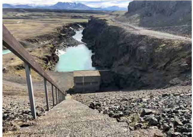
Botnlokuhús, horft til suðvesturs, 2019.
