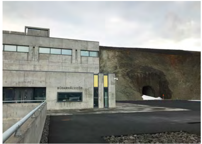
Stöðvarhús, horft úr norðvestri. Opinn skurður í bakgrunni, 2019.
