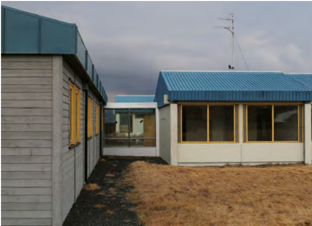
Starfsmannahús, horft úr suðri, 2019.
