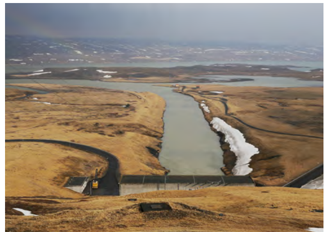
Suðurhlíð stöðvarhúss og frárennisskurður til norðurs, 2019.
