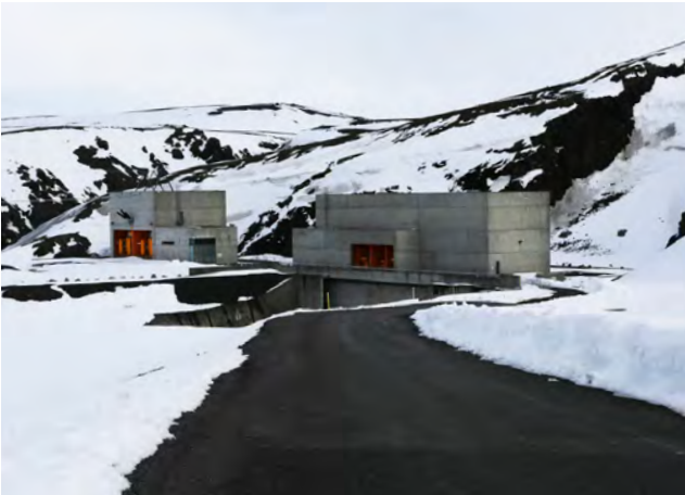
Tengivirkishús og stöðvarhús, horft úr suðvestri, 2019.
