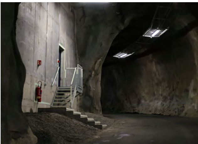
Steypfir veggur og bergveggur í gangnamannvirki, 2019.
