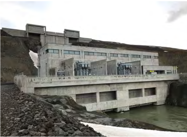
Norðvesturhlíð stöðvarhúss. Inntakshús að ofanverðu, 2019.
