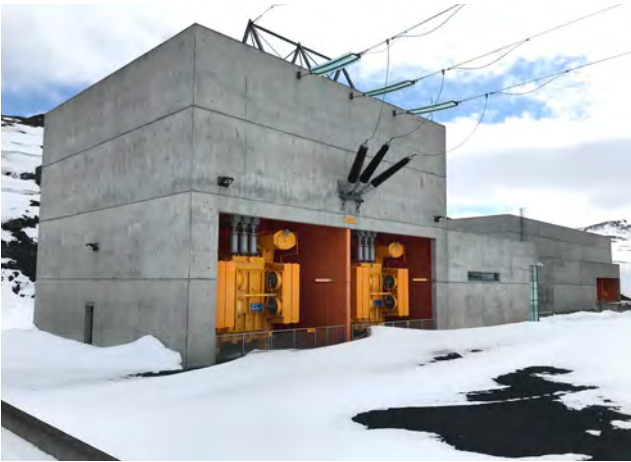
Tengivirkishús, norðvesturhorn. Stöðvarhús í bakgrunni, 2019.
