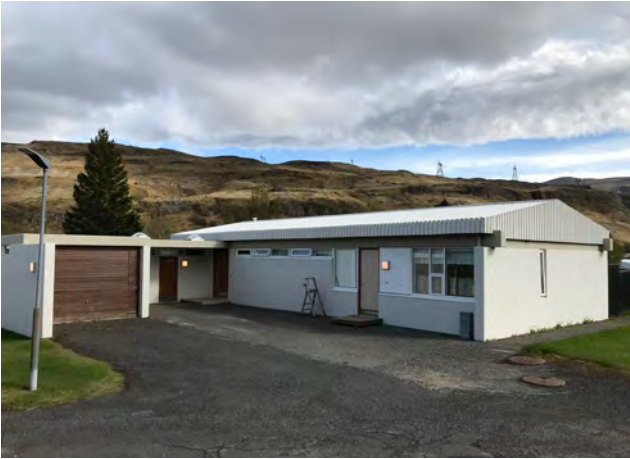
Íbúðarhús, horft úr norðvestri, 2019.
