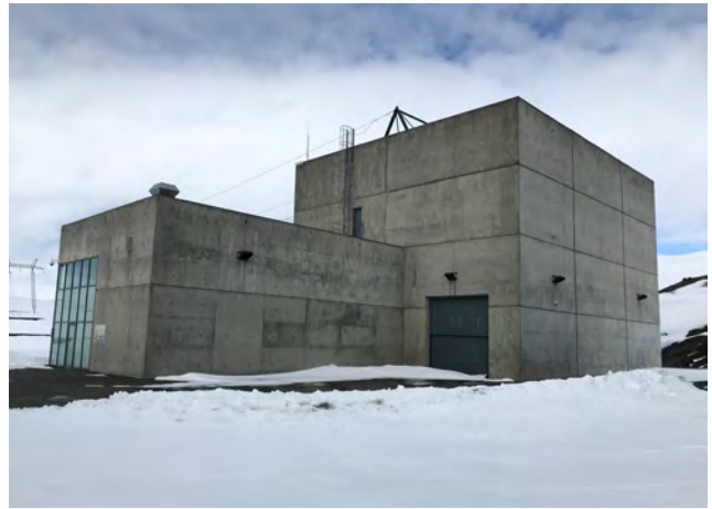
Tengivirkishús, horft úr suðaustri, 2019.
