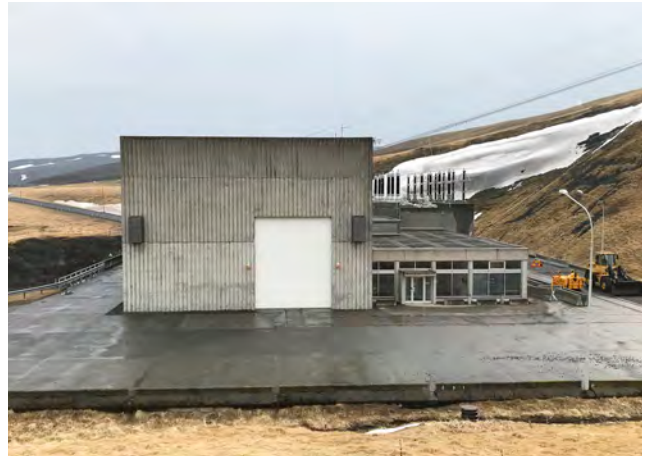
Inngangur er við vesturgafli stöðvarhúss, 2019.
