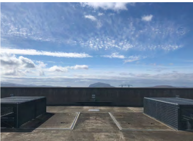
Steypt þak inntakshús myndar aðkomupall, horft til suðvesturs. Búrfell í fjarska, 2019.
