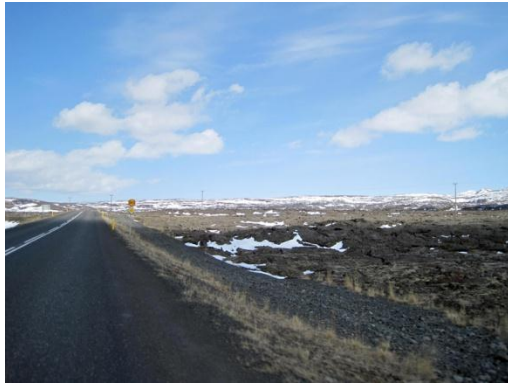
Mynd 5.2 Hitaveitulögn meðfram vegi.
