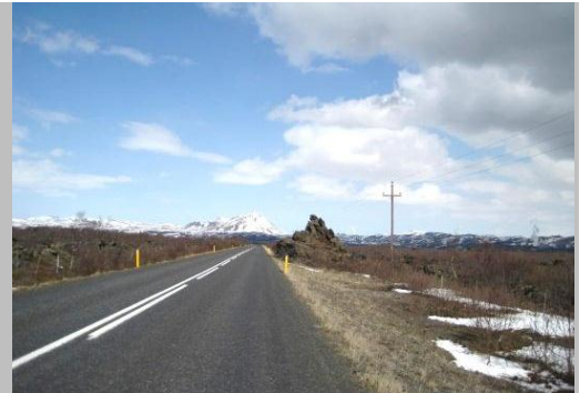
Mynd 5.13 Mývatnssveitarvegur (848) við Voga.
