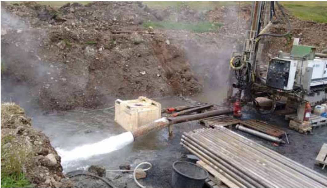
Hola SK-16 á Skeggjabrekkudal loftdæld í lok borunar. Jarðborinn „Gudda“ boraði holuna, borvertaki var Þórsverk og borstjóri Magnús Gíslason. ÍSOR sá um rannsóknir og vísindalega ráðgjöf.
