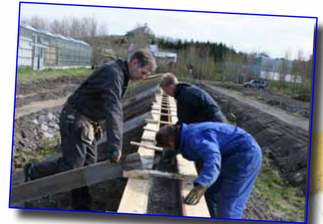
Nýja gróðurhúsið í byggingu
