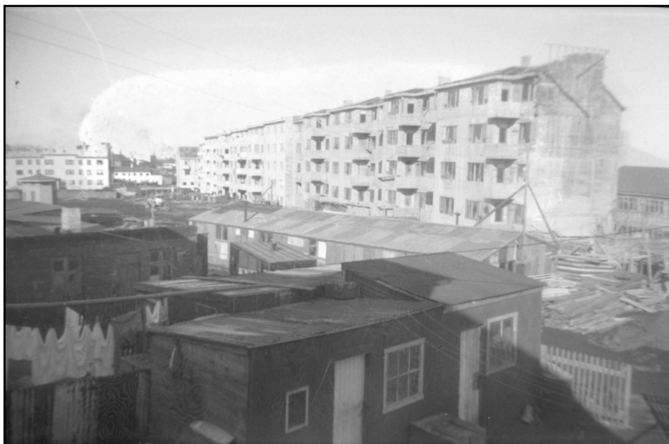
Fjölbýlishúsin við Skúlagötu í byggingu. 15
