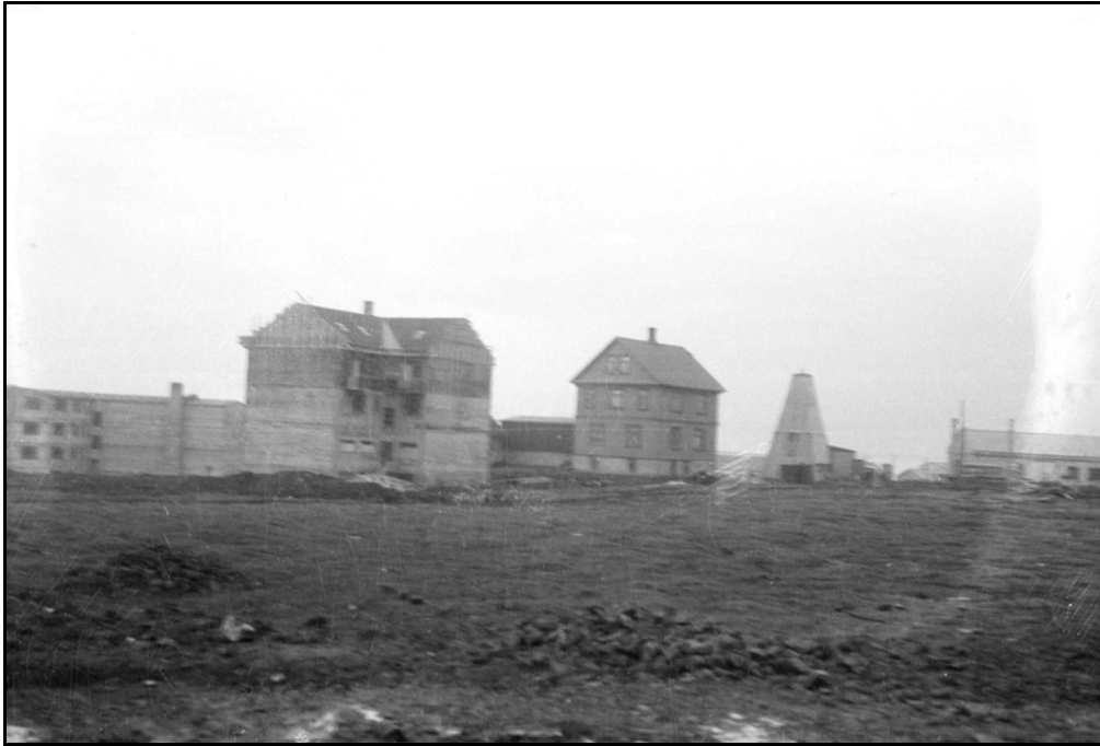
Rauðarárstígur 1 í byggingu. Bærinn Rauðará fyrir miðri mynd. 19
