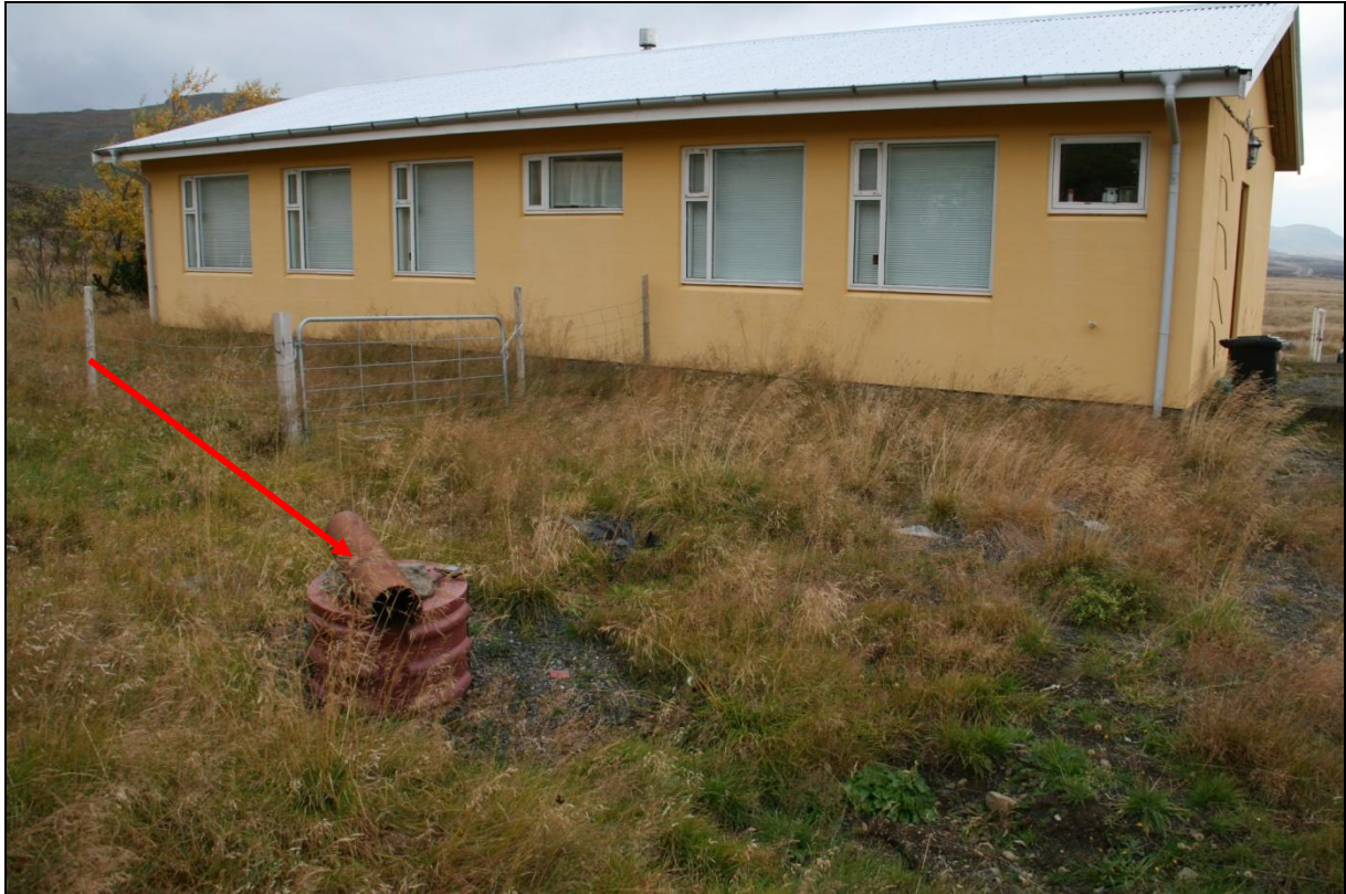
14. mynd. Borhola BB-02 á Breiðabólstað. Íbúðarhúsið í baksýn.
