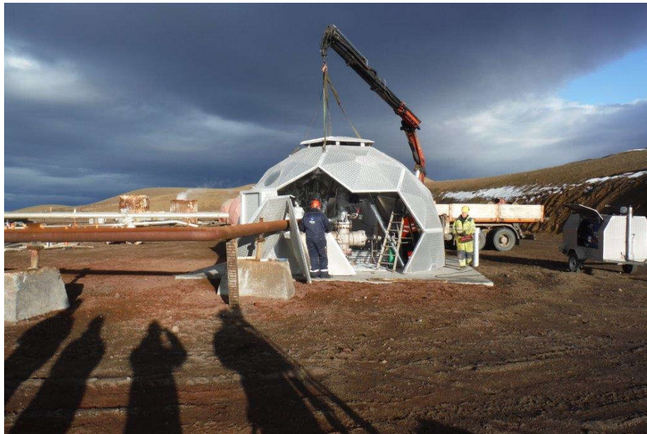
Mynd 2: Gengið frá húsi yfir holutopp við Kröflu.
