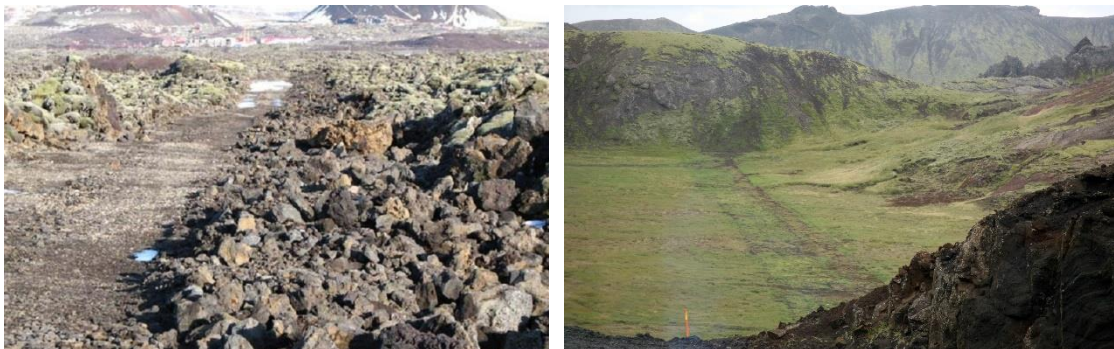
Mynd 5.6. Frágangur eftir jarðlagnir er misauðveldur eftir aðstæðum. Myndin til vinstri er tekin af fari eftir lagningu vatnslagnar Orkuveitu Reykjavíkur í Grábrókarhrauni í Borgarfirði. Myndin til hægri er af fari eftir lagningu Nesjavallalínu 2, 132 kV jarðstrengs í Dyradölum á Nesjavallaleið. Þar var jarðstrengur grafinn milli móbergsása og strengslóð fjarlægð að lagningu lokinni.
