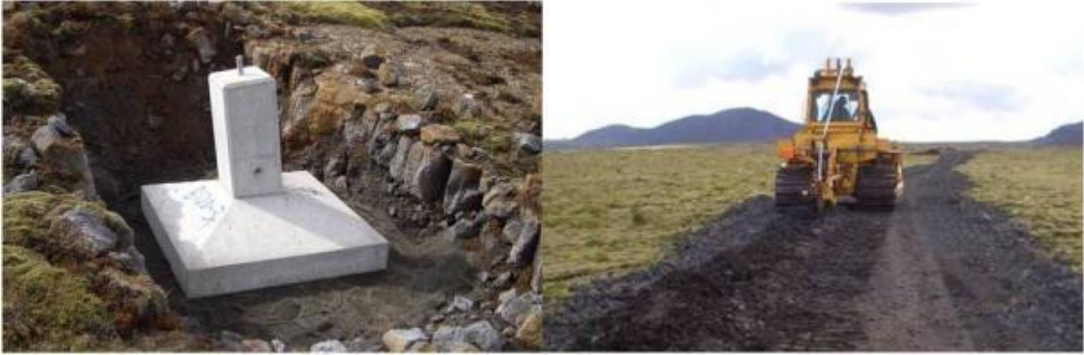
Mynd 5.4. Til vinstri má sjá hvar grafíð hefur verið fyrir forsteypri undirstöðu masturs og til hægri sést hvernig jarðskaut er plægt í kant vegslóðar.
