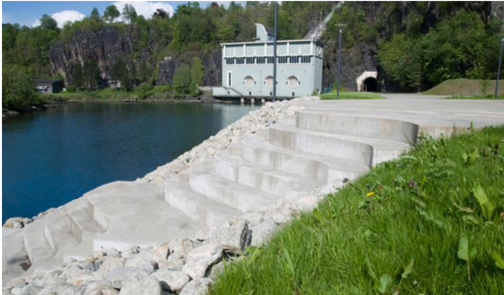
mynd 10: Hér er dæmi af áningarstað sem komið hefur verið fyrir við stöðvarhús. (Sønná kraftverk, Norconsult AS)
