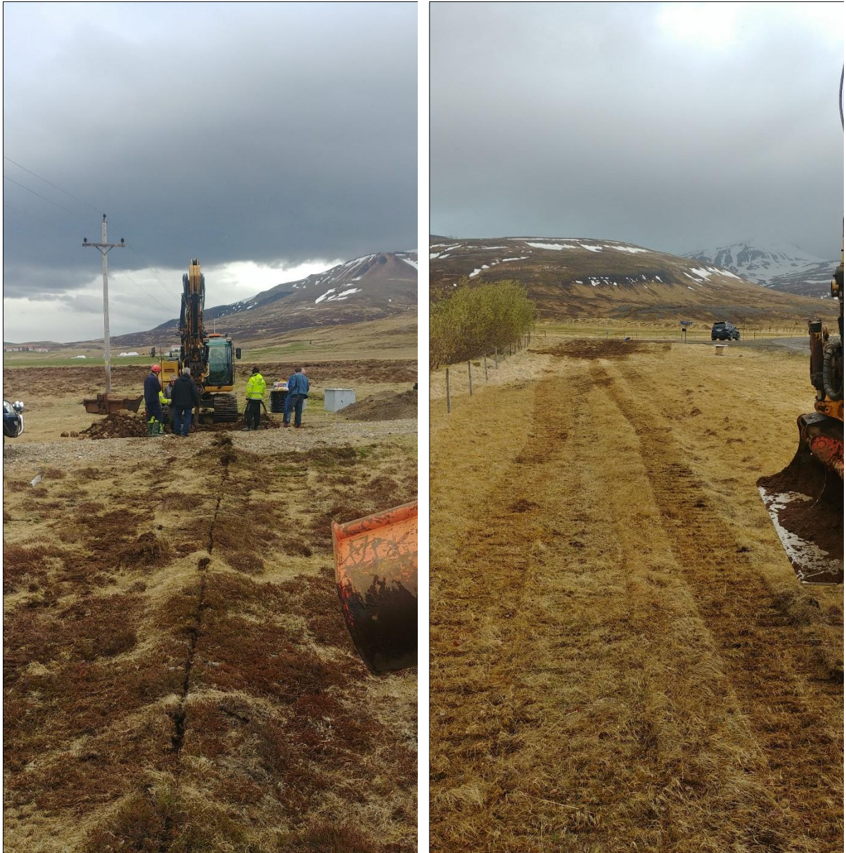
Mynd 3.7 Myndir sem sýna ummerki eftir lagningu 11 kV strengs. Á myndinni til vinstri hefur strengur verið plægður niður en frágangur er eftir. Myndin til hægri sýnir ummerki að frágangi loknum.
