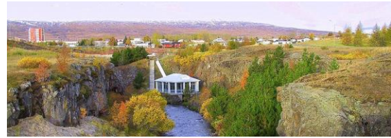
Glerárvirkjun (Uppsett afl 290 kW, Ljós. Norðurorka)
