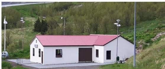
Stöðvarhús Búðarárvirkjunar, (Uppsett afl 250 kW. Ljósmynd Rafveita Reyðarfjarðar)
