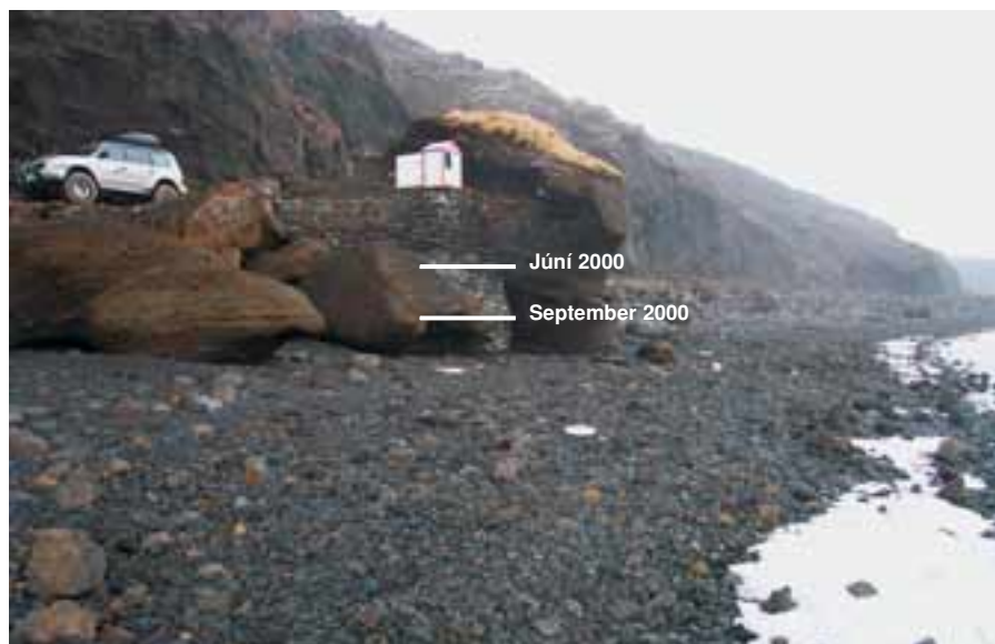
Brunnsíritinn í Kleifarvatni sem skráði vatnshæð þess, frá árinu 1963 til ársloka árið 2000, stendur nú á þurru landi. Punktalínurnar á myndinni sýna hæð vatnsborðsins, annars vegar í júní 2000 og hins vegar í september 2000, myndin var tekin í mars 2001. Vatnshæð Kleifarvatns hefur lækkað um rúmlega 4 metra síðan í júní 2000 þegar jarðskjálftar skóku svæðið. Þurrkatíð nægir ekki til að skýra lækkun vatnsborðsins en sprungur á botni Kleifarvatns hafa líklega opnast við skjálftana og aukið leka Kleifarvatns til grunnvatnsins. Óvíst er hversu lengi vatnsborð Kleifarvatns mun halda áfram að lækka. Ljós. Sigvaldi Árnason.
