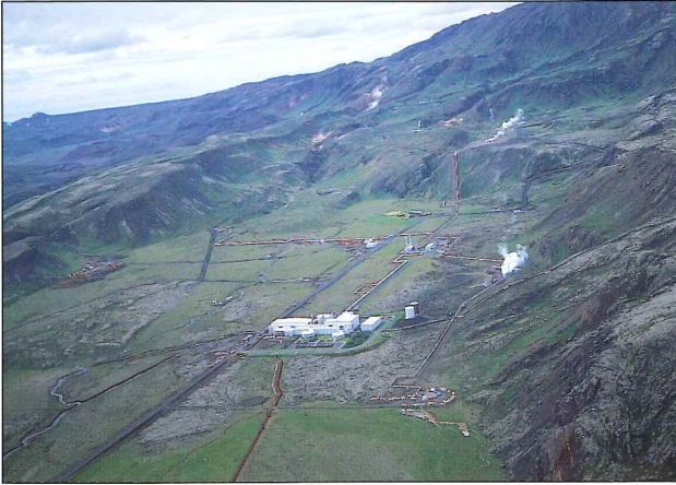
Raforkuver Hitaveitu Reykjavíkur á Nesjavöllum, sem er knúð 2 x 30 MW eimsvalahverflum, var gangsett á árinu. Lokið var endurskoðun hermireikninga fyrir Nesjavallakerfið og mat á þeim bendir til að hagkvæmt sé að stækka virkjunina sem nemur 30 MW í rafafli. Ljós. Oddur Sigurðsson.
