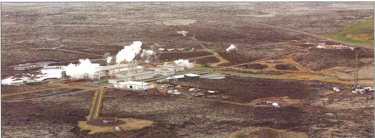
Í Svartsengi voru boraðar þrjár vinnsluholar og ein niðurdælingarhola í 2,5 km fjarlægð frá vinnslusvæðinu. Til hægri á myndinni er borinn Jötunn við borun holu 19, sem varð 1600 metra djúp. Ljósm. Hjalti Franzson.
