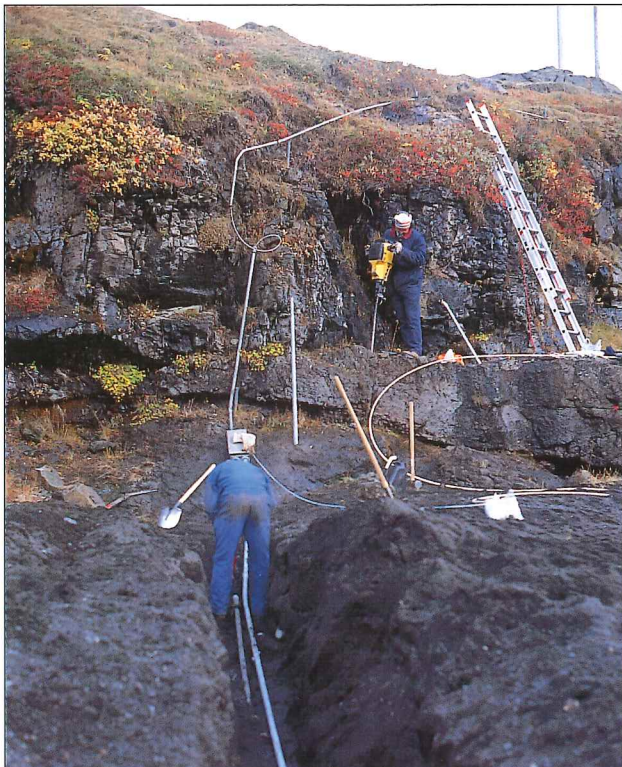
Unnið að framkvæmdum við sírita í Blöndu nærri Blönduósi. Eldri gassíriti var lagaður og þrýstiskynjara komið fyrir sem hægt er að lesa af um síma hjá Vatnamælingum í Reykjavík. Ljós. Bjarni Kristinsson.
