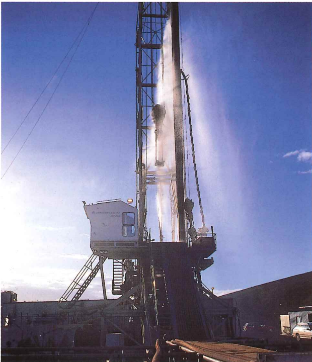
Loft og vatn frussast upp úr sundurteknum borstreng á holu KJ-30 í Suðurhlíðum Kröflu. Verkið er liður í stækkun virkjunarinnar í 60 MW. Ljós. Sigurður Sveinn Jónsson.
