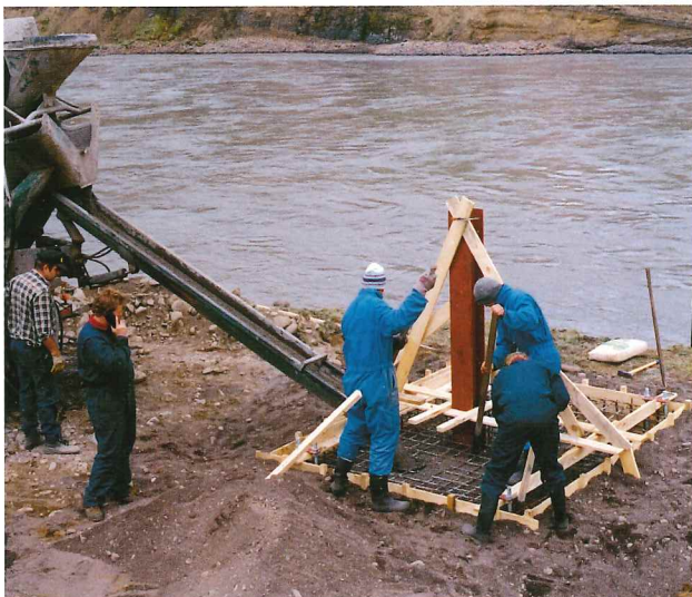
Unnið að smíði kláffestu við Jökulsá á Dal við Hjarðarhaga. Ljósmynd. Snorri Zóphóniasson.
